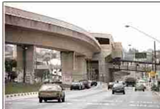
Fonte: CMSP, 2005 Figura 37 – Metrô elevado
