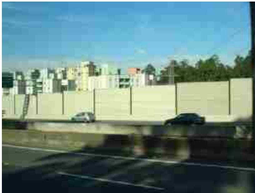
Figura 03 – Barreira acústica instalada na Rodovia dos Bandeirantes em São Paulo
