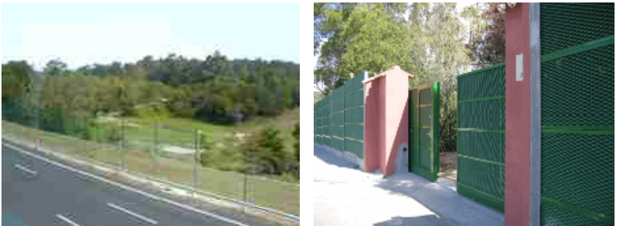
Fonte: COMPLAGE, 2007 Figura 29 – Barreiras acústicas de parques
