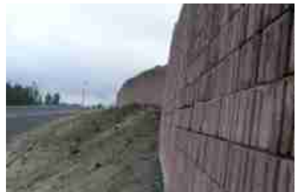
Figura 27 - Barreira acústica de elemento pré-fabricado de concreto leve com aplicação linear
