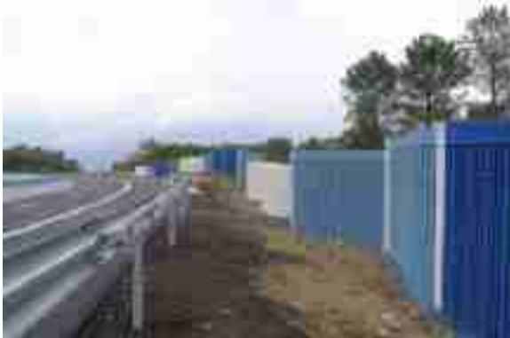
Figura 26 - Barreira acústica de elemento pré-fabricado de concreto leve com aplicação ondulada
