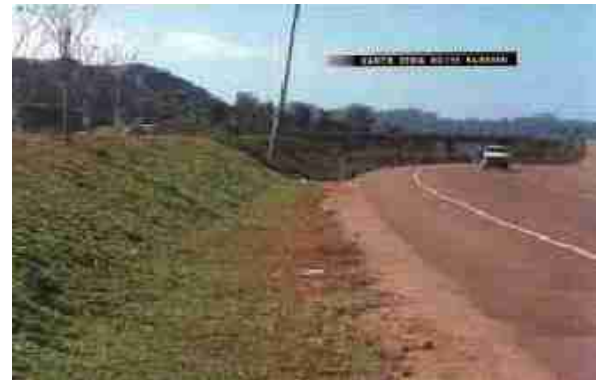
Figura 25 - Barreira acústica construída com berma de terra
