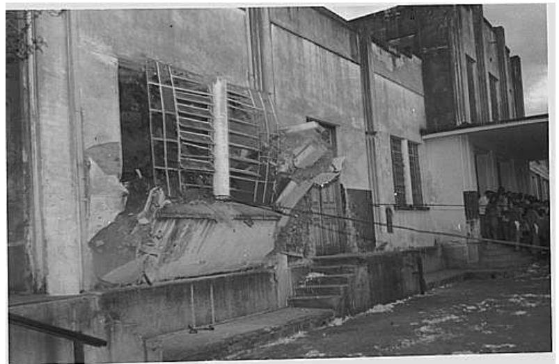
Foto 15 – Demolição Estação da Mogiana
