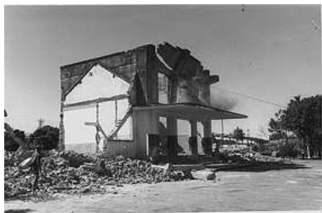
Foto 20 – Demolição E. Mogiana
