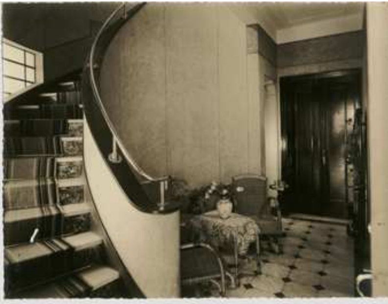
Foto 45 – Interior de residência
