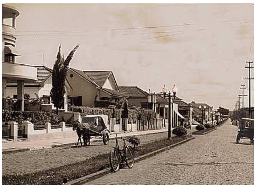
Foto 30 – Av. João Pinheiro sem data. 51
