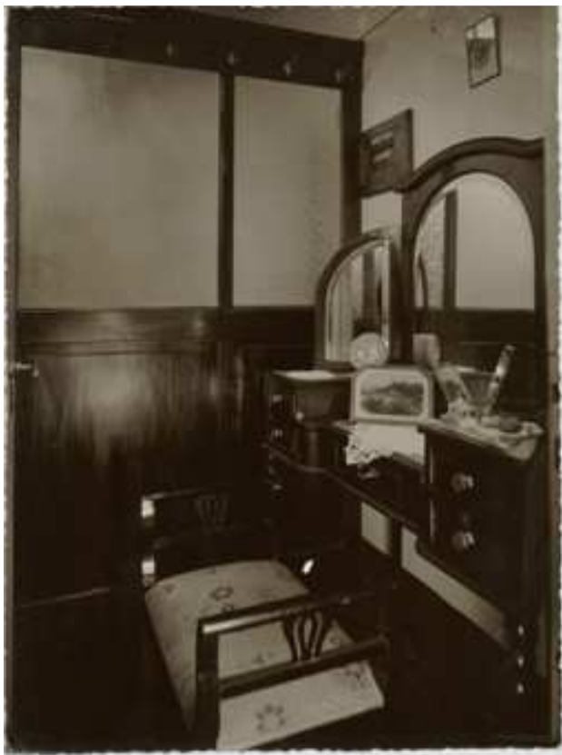
Foto 46 – Interior de residência
