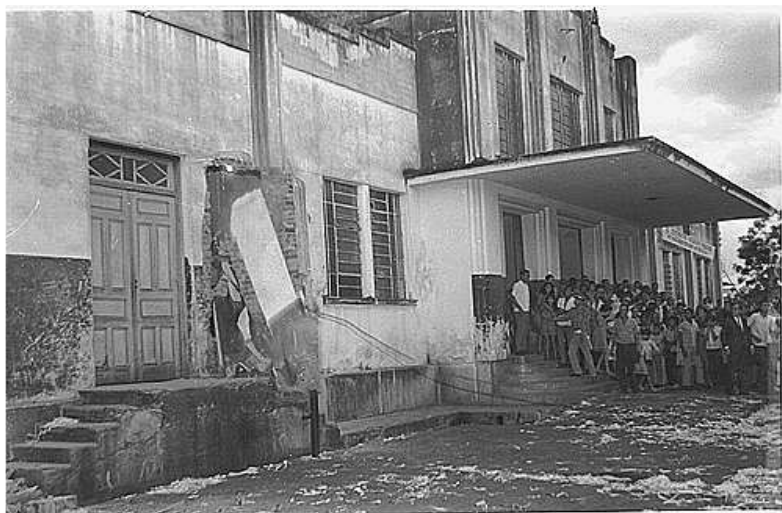
Foto 16 – Demolição Estação da Mogiana
