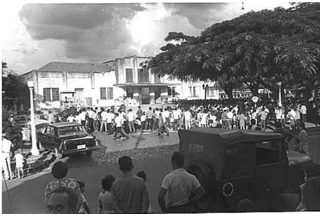
Foto 11 – Demolição da Estação Ferroviária da Mogiana 14/04/1970. 16
