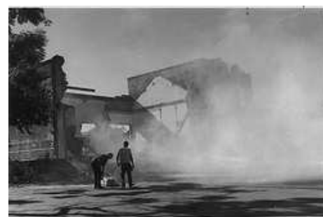
Foto 19 – Demolição E. Mogiana
