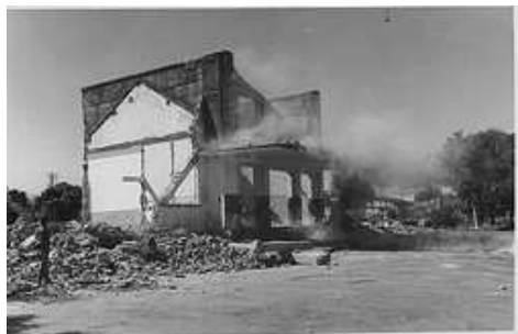
Foto 21 – Demolição E. Mogiana
