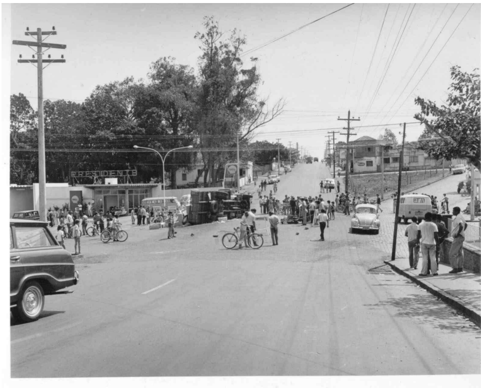
Foto 26 - Aglomeração de pessoas no acidente envolvendo caminhão
