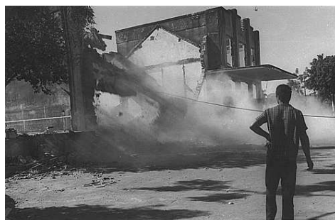
Foto 18 – Demolição E. Mogiana
