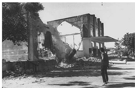
Foto 17 - Demolição E. Mogiana
