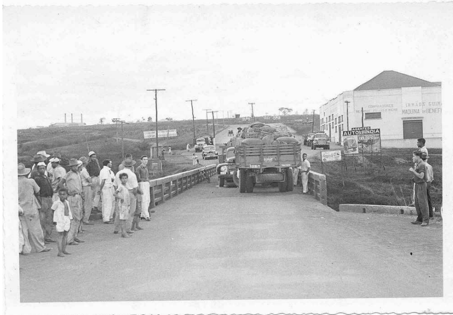
Foto 20 - Ponte do Vau aproximadamente década de 50.
