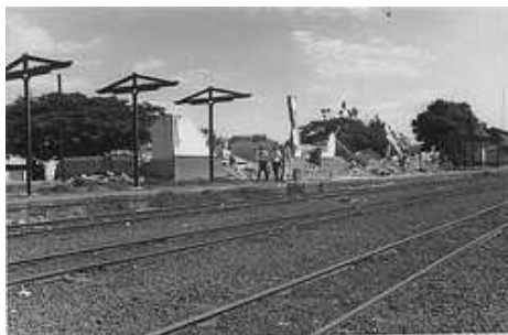
Foto 22 – Demolição E. Mogiana
