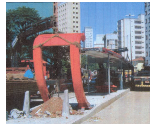
imagem 91. A implantação exige grandes máquinas e interdição de parte da via. Nesta foto, temos dois guindastes, enquanto um suportando a curva terminal, outro posiciona a estrutura horizontal da cobertura, que é descarregada do caminhão emparelhado.
