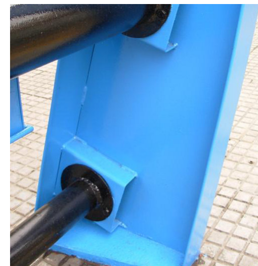
imagem 116. e imagem 117. Variações da fixação do tubo horizontal dos bancos em peças executadas por diferentes firmas; e variação na fundação.
