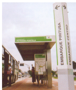
Figura 10: Abrigo modelo Inox instalado no Corredor Pirituba-Lapa-Centro com painel informativo e totens de orientação. (fonte: SPTrans, 2004)
