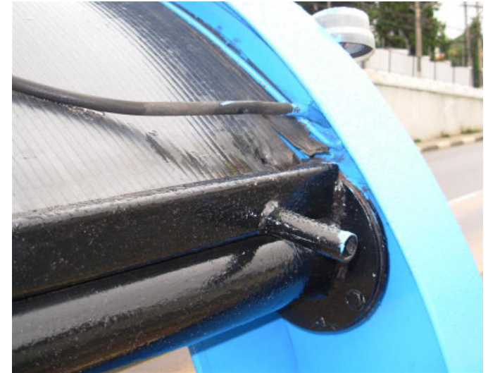
imagem 102. e imagem 103. e imagem 104. Detalhes do SP450: painel informativo curvado, conjunto de luminária, captação pluvial e fotocélula para acionamento automático da luz...
