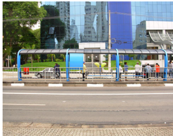
imagem 100. Aspecto geral posterior de um conjunto instalado; a cobertura não tolera muitas inclinações.
