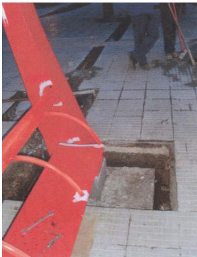
imagem 112. e imagem 113. e imagem 114. Aspectos da implantação: fundação leve, estrutura não finalizada mas estável, baixa quantidade de mão-de-obra, pouca interferência no local e no fluxo, trabalhando sobre piso já instalado.
