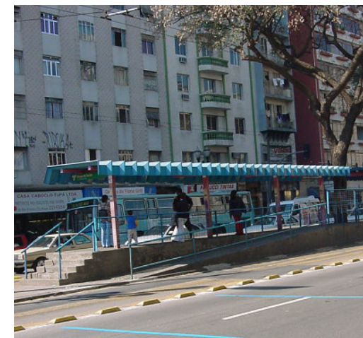
imagem 54. Abrigos no corredor Rio Branco, com embarque “alto”, a 120cm da via. Foram adaptados para a proposta atual do Sistema Interligado, com embarque “baixo”, a 32cm da via.
