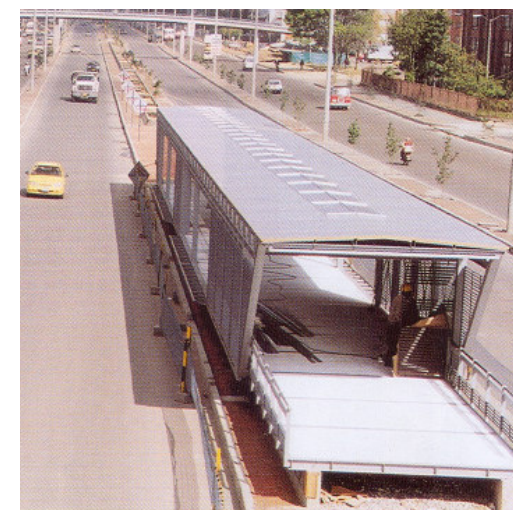
imagem 63. Montagem do abrigo do TransMilenio, Bogotá, Colômbia.
