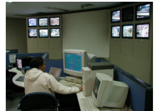
imagem 57. Central de Informações, no Terminal Lapa, que gerencia veículos e corredores. As informações da localização dos carros pode ser repassada aos painéis digitais, instalados nos abrigos ao longo das linhas.
