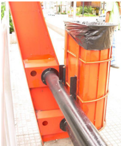
imagem 105. e imagem 106. e imagem 107. e imagem 108. ...fixação dos tubos horizontais e da lixeira, acesso de infra-estrutura no piso, fixação dos bancos, caixa externa para câmera de vigilância.
