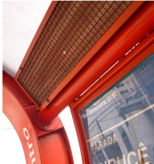
imagem 102. e imagem 103. e imagem 104. Detalhes do SP450: painel informativo curvado, conjunto de luminária, captação pluvial e fotocélula para acionamento automático da luz...
