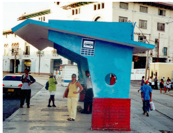
imagem 41. ...Cuba, concreto armado, anos 2000...
