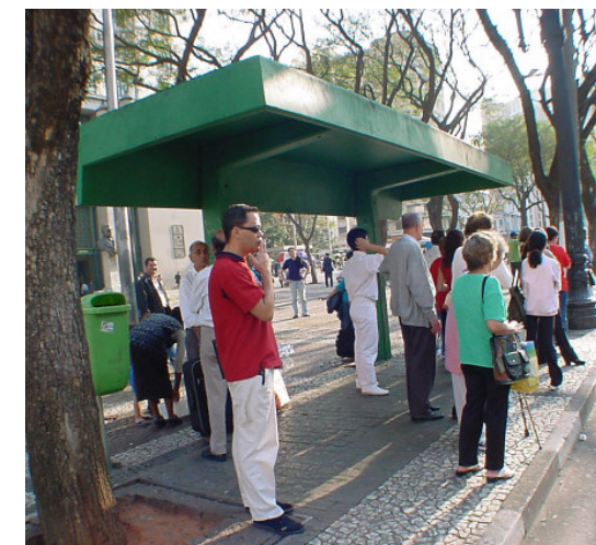
imagem 49. Em concreto armado, que equipava alguns pontos no centro e no corredor 09 de Julho, já removidos.
