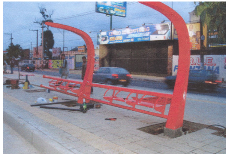
imagem 112. e imagem 113. e imagem 114. Aspectos da implantação: fundação leve, estrutura não finalizada mas estável, baixa quantidade de mão-de-obra, pouca interferência no local e no fluxo, trabalhando sobre piso já instalado.
