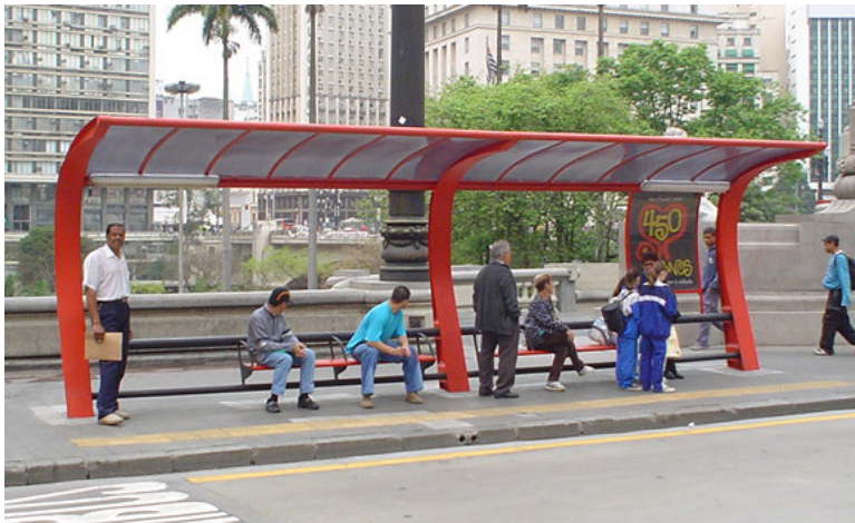
imagem 96. e imagem 97. Aspecto geral do SP450 instalado.
