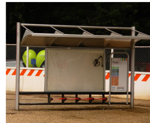
imagem 21. O conjunto instalado dos abrigos “Barcelona” é resultado de uma concessão municipal de exploração de propaganda em abrigo de ônibus, tendo como contrapartida a instalação e manutenção dos mesmos. Av Paulista, SP.
