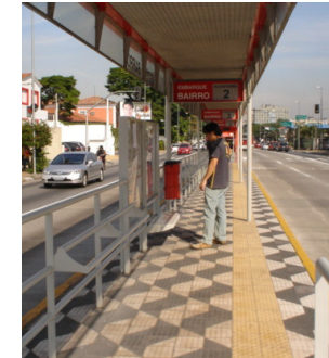
Figura 1: Ponto de parada em corredor de ônibus, com piso tátil de alerta, apoio glúteo, painéis informativos e lixeira (fonte: SPTrans, 2007)
