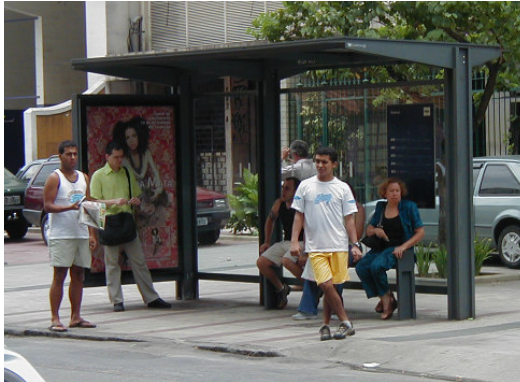
imagem 37. Alguns exemplos de abrigos de ônibus: Rio de Janeiro, bairro do Botafogo, RJ, metálico, anos 2000, ...
