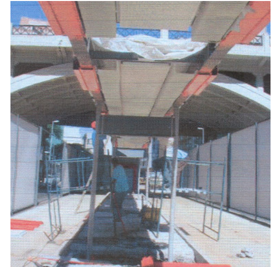
imagem 80. Aspecto interno da montagem do B&C: a grande estrutura do perímetro é fechada com cobertura independente.
