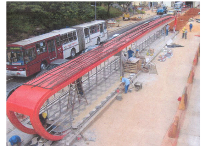
imagem 80. Aspecto interno da montagem do B&C: a grande estrutura do perímetro é fechada com cobertura independente.
