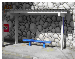
Figura 5: Abrigo de concreto (fonte: SPTrans, 2007)
