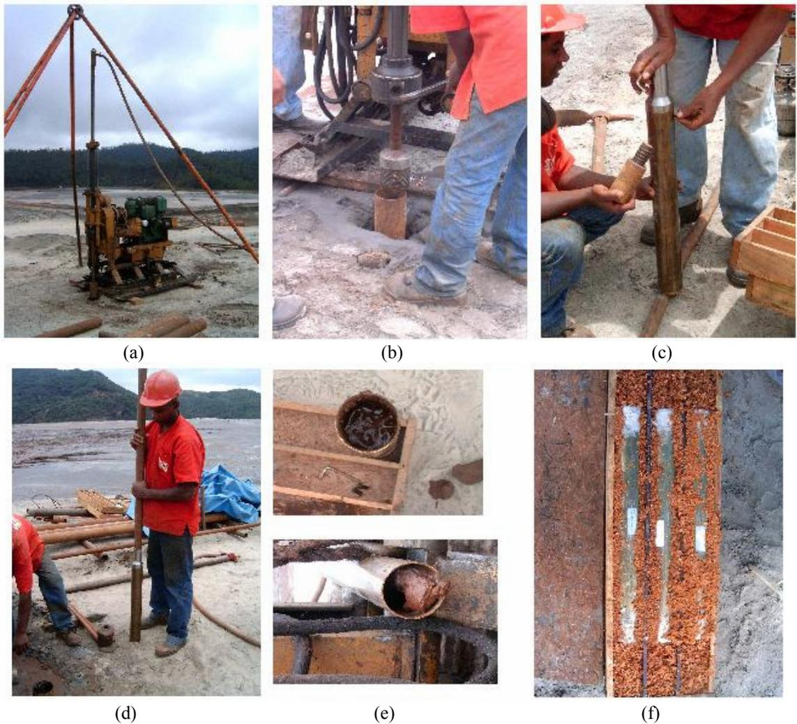
**Figura 3.9 – Amostragem tipo Shelby, (a) equipamento de sondagem mista utilizado no avanço da sondagem, (b) detalhe do tubo de revestimento, (c) amostrador Shelby, (d) montagem do amostrador, (e) amostras coletadas e, (e) acondicionamento dos shelbies nas caixas com as camisas envoltas com serragem úmida**
