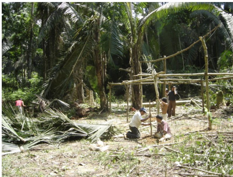
Figura 17: A construção do novo tapiri.
