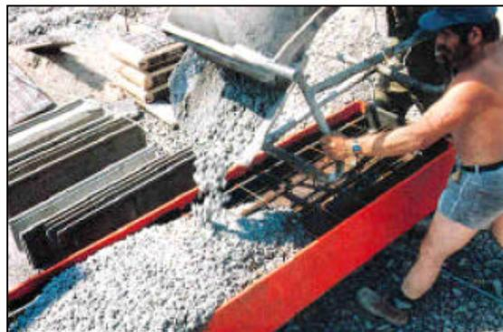
Figura 2.5 – Concretagem de pilar misto parcialmente revestido. (Stark, 2001)
