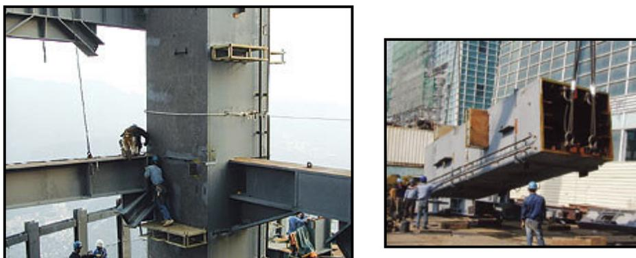
Figura 1.4 – Edifício Taipei 101 – Pilares Preenchidos (enr.construction.com).
