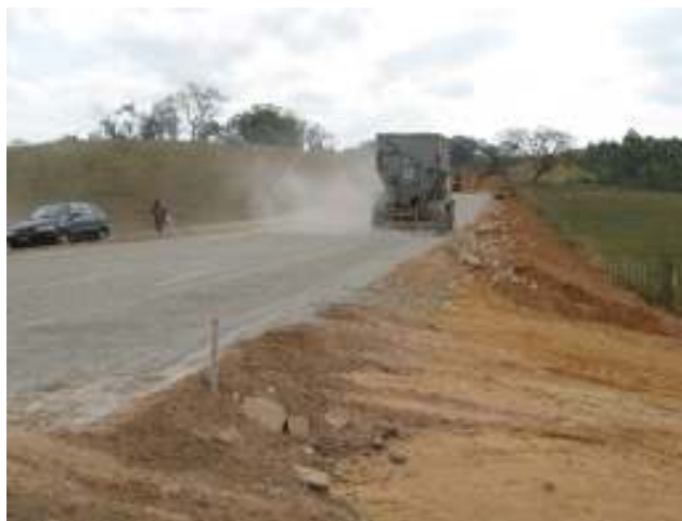
Figura 2.9- Aplicação de cimento Portland (BR 459- trecho Pouso Alegre- MG Congonhal- MG).
