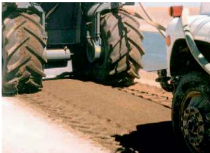
Figura 2.8- Material reciclado no processo com espuma de asfalto.
