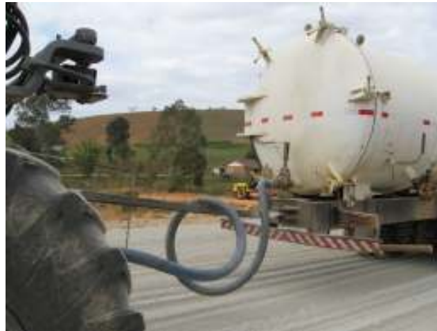
Figura 2.11- Recicladora abastecida pelo caminhão tanque na reciclagem (BR 459- trecho Pouso Alegre- MG- Congonhal- MG).
