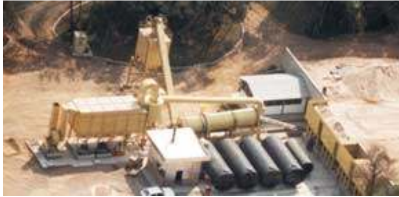
Figura 2.15- Usina Drum Mixer – Cifali. Fonte Trimak (2006).
