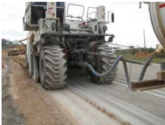
Figura 2.12- Mistura do material reciclado ao cimento. (BR 459- trecho Pouso Alegre- MG- Congonhal- MG).
