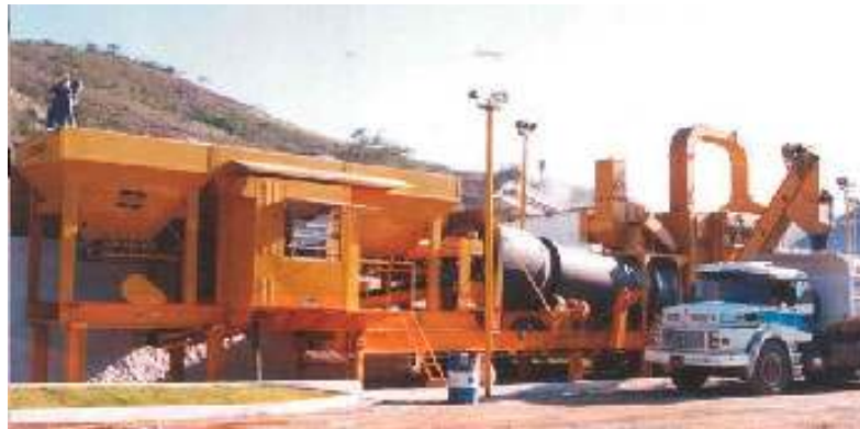
Figura 2.14 Usina Drum Mixer RD 110- Cifali. Fonte: Cotril (2006).
