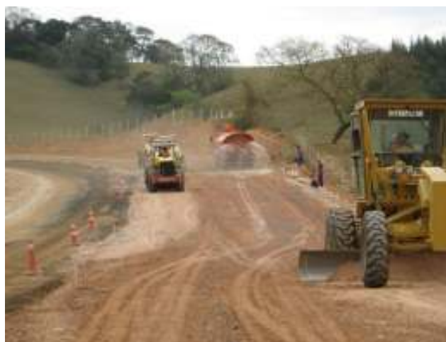
Figura 2.10- Distribuição de água. Portland (BR 459- trecho Pouso Alegre- MG- Congonhal- MG).
