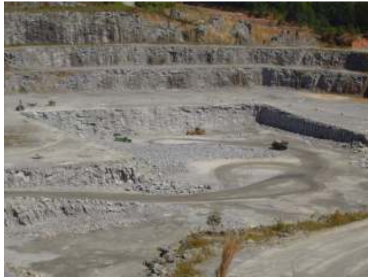
Figura 2.4- Pedreira de Embu, em São Paulo.
