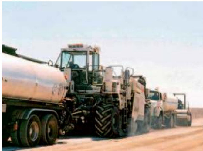
Figura 2.7- Equipamentos em reciclagem com espuma de asfalto.
