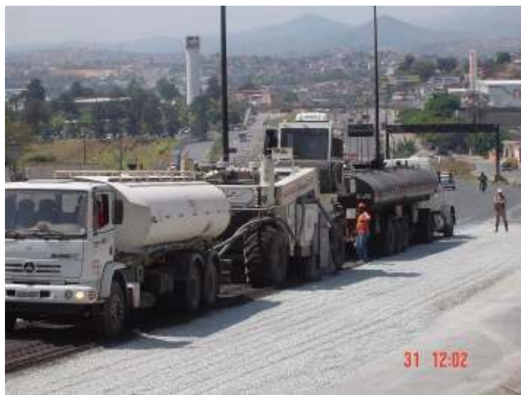
Figura 2.24-. Recicladora com caminhão tanque de água em operação. Cedido por Oliveira (2003).
