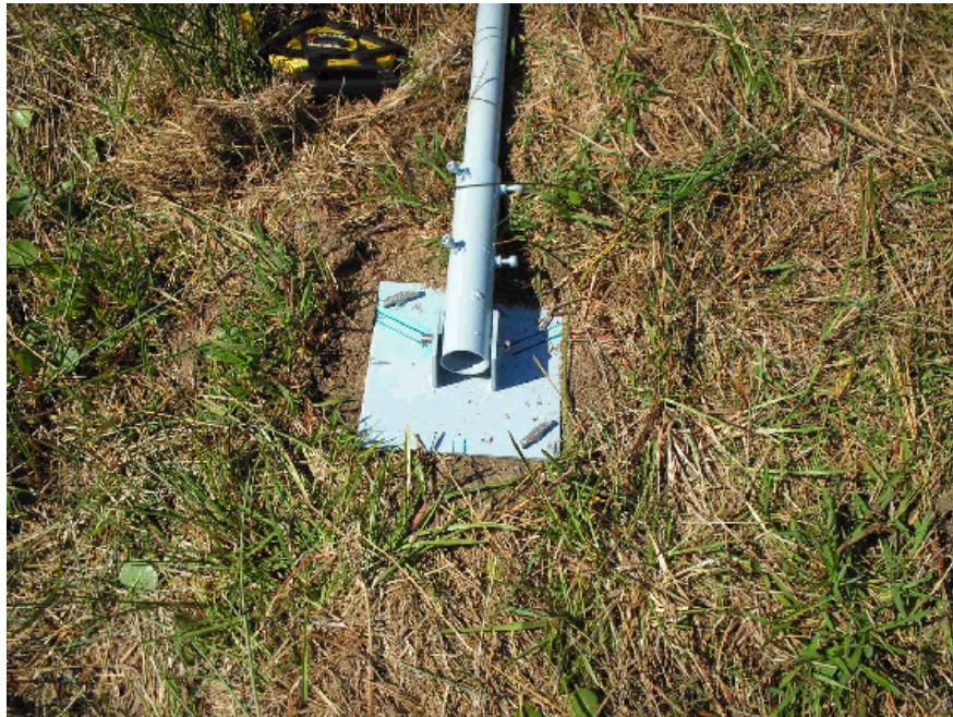
Figura 3.8 – Torre fixada à base
