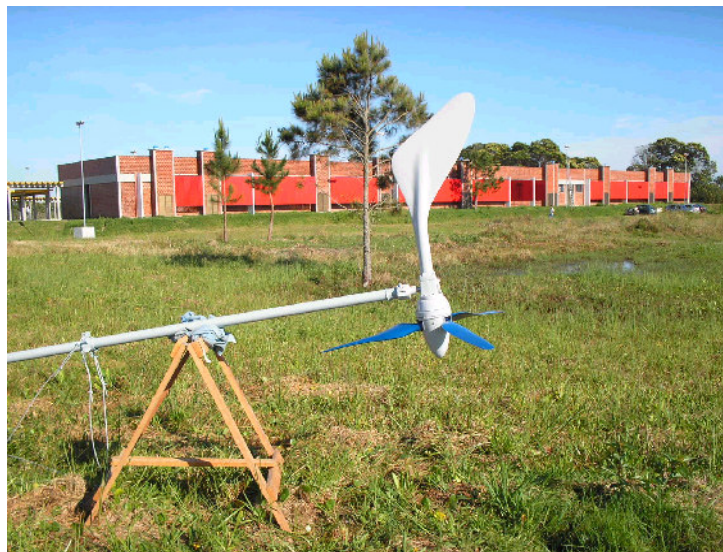
Figura 3.16 – Montagem do Aerogerador na Torre
