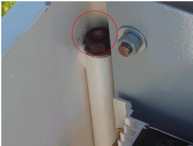
Figura 3.15 – Forma de Fixação da Caixa de proteção
