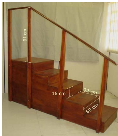
Figura 12. Escada construída com dimensões conforme as normas da ABNT.
