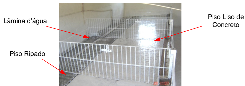
Figura 36 - Detalhe interno das salas de creche com detalhes do tipo de piso e separação das baias
