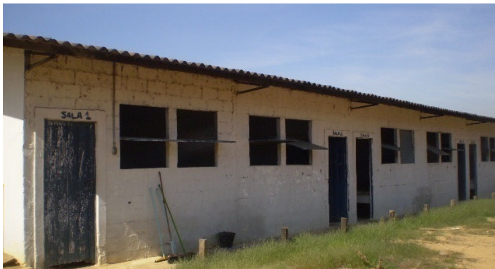
Figura 34 - Vista frontal de parte da instalação
