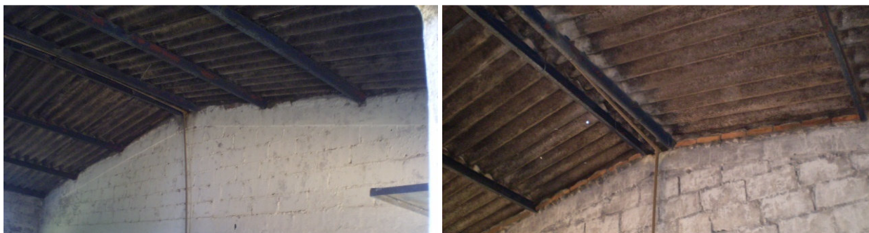
Figura 35 - Detalhe do telhado no interior da instalação
