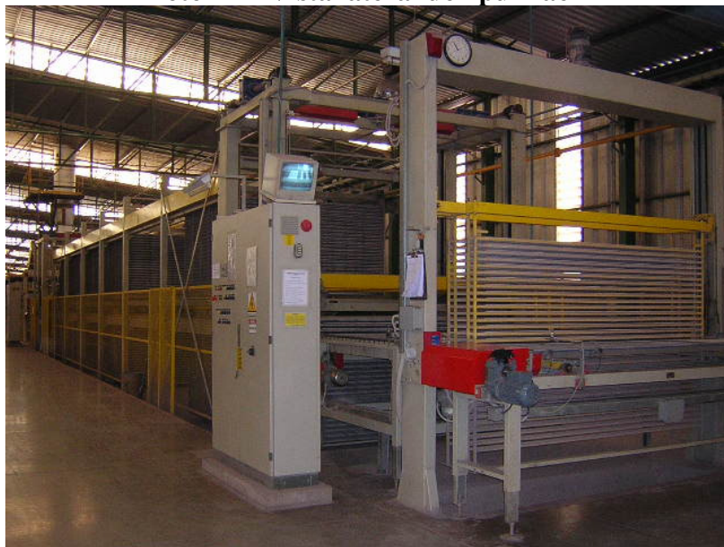
Foto 14 – Vista lateral do “pulmão”
