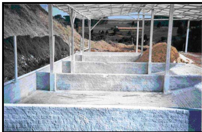
Figura 3. Tanques para tratamento de dejetos recebendo o substrato.
