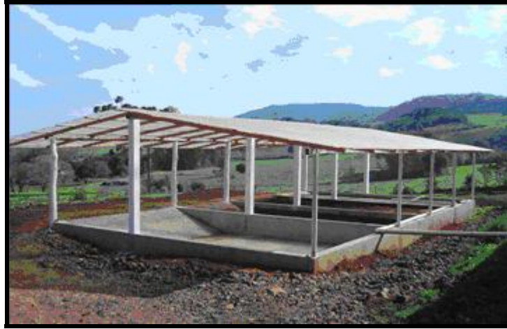
Figura 10. Tanque para realização da fase 2.
