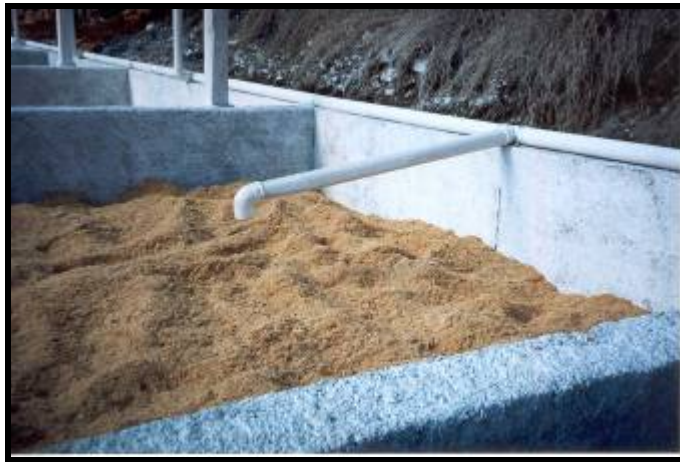
Figura 5. Tanque pronto para receber os dejetos líquidos, onde observa-se o cano de PVC posicionado para iniciar a impregnação.
