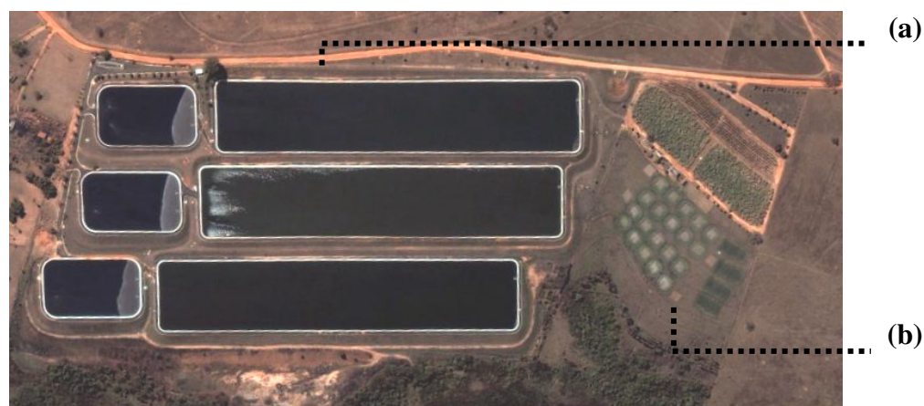
Figura 1 – (a) ETE de Lins (Lagoas de estabilização) e (b) Área experimental
