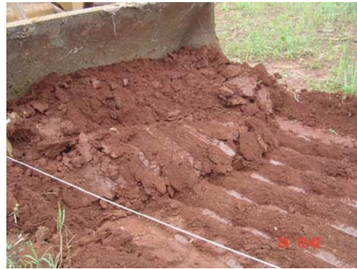
Foto 2 – Raspagem do solo (simulação erosão)
