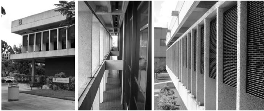
Figura 174, 175, 176 - Edifício que abriga atividades administrativas. Fotos de set. 2005
