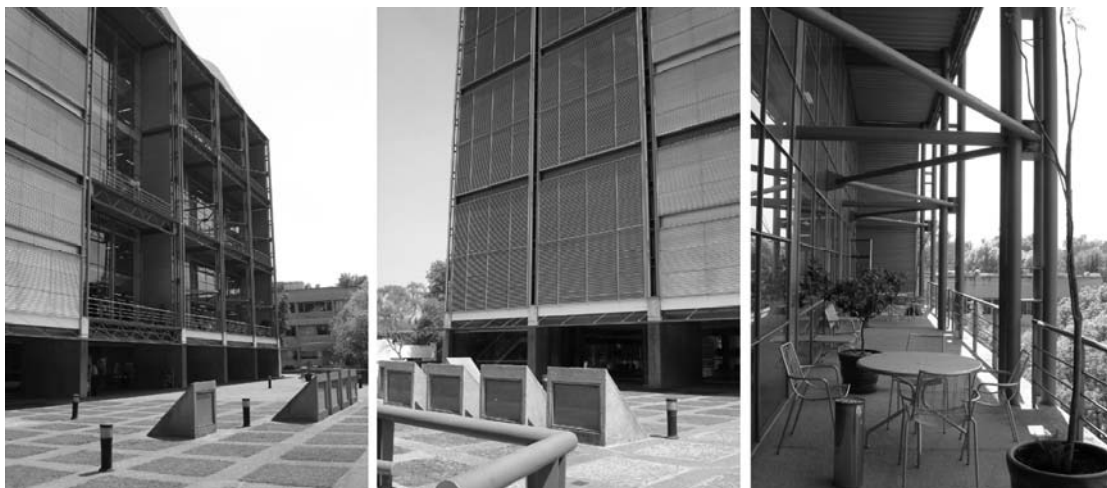
Figura 211, 212, 213 - Edifício da Engenharia da UNAM. Fotos de fev. 2006
