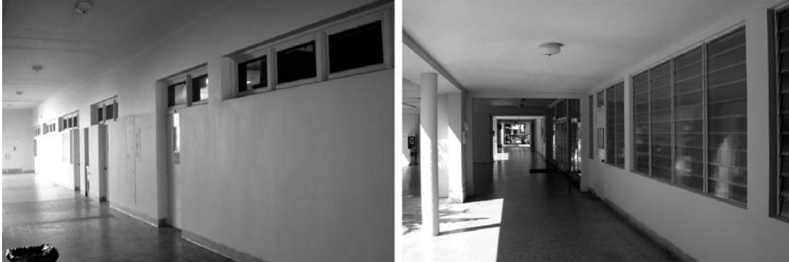
Figura 169 e 170 - Corredores das salas de aula do edifício de Ciências da Barry University . Fotos de set. 2005
