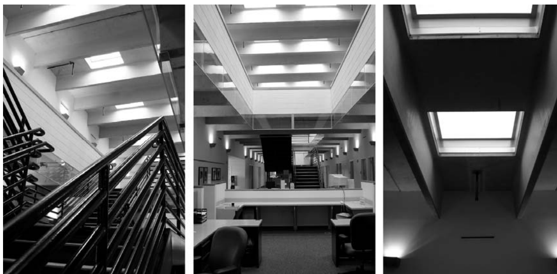
Figura 198, 199, 200 - Edifício administrativo da Escola de Arquitetura da FIU. Fotos de set. 2005.
