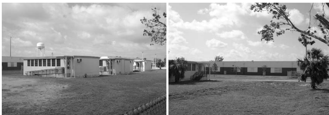
Figura 201, 202 - Escola em Fort Lauderdale: edifício principal ao fundo, salas de aula temporárias a frente. Fotos de mar. 2006
