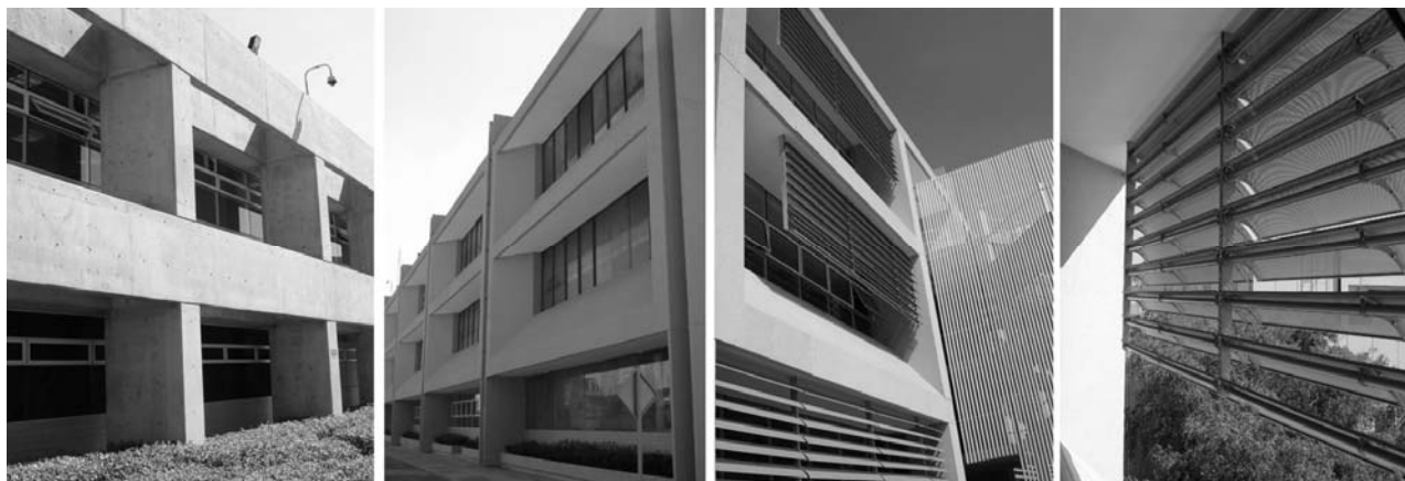
Figura 245, 246, 247, 248 - Fachadas de diferentes edifícios no campus Coyoacán da UNITEC. Fotos de fev. 2006
