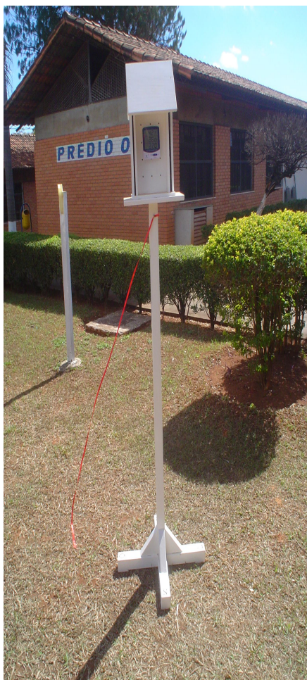
Foto 11: Abrigo meteorológico instalado na Escola Técnica
