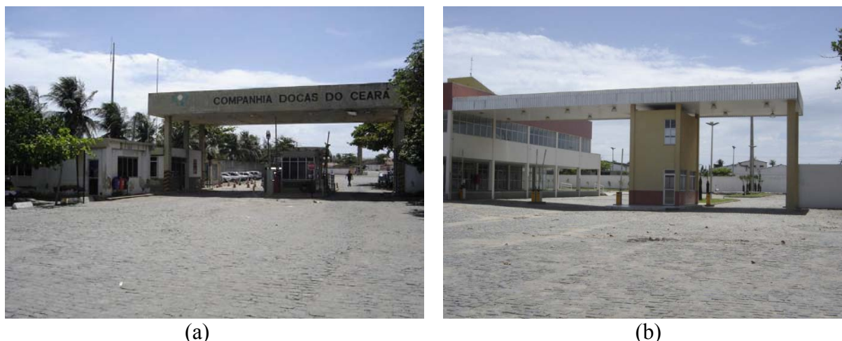
Figura 3.1 – (a) Portão para entrada e saída de veículos do Porto de Fortaleza até o início de 2008 e (b) Novo Portão para entrada e saída de veículos do Porto de Fortaleza a partir de julho de 2008
