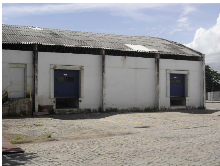
Figura 3.4 – Armazém para inspeção de cargas refrigeradas do Porto de Fortaleza em 2008
