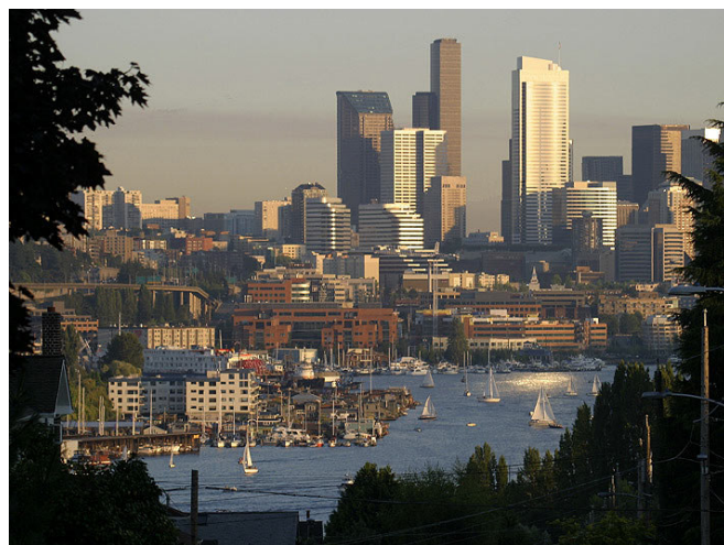
Fig. 46. Vista evidenciando o Waterfront Place em Seattle. Fonte: http://www.seattletoursaver.com
