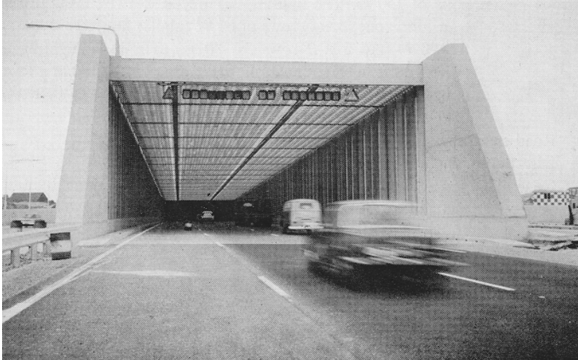
ILUSTRAÇÃO 79 – Túnel Schiphol: Vista do Emboque Sul FONTE – GRAAFF In: BOER, 1967, p.659
