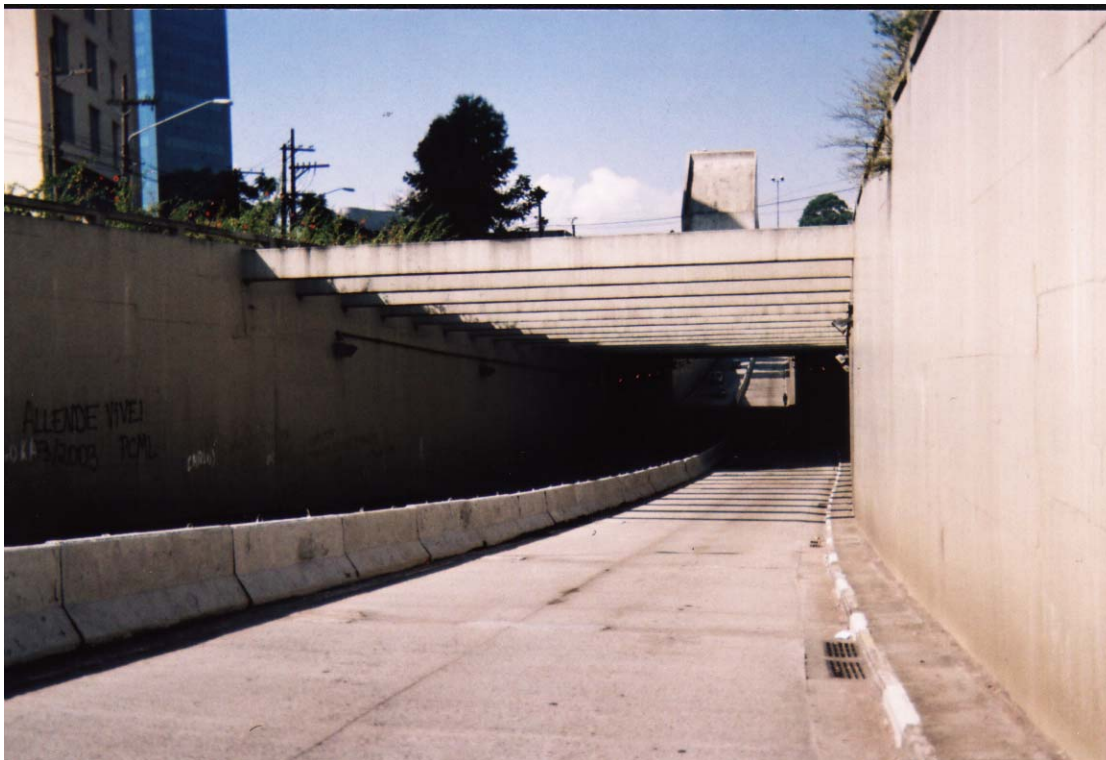
ILUSTRAÇÃO 93 – Passagem Inferior Zerbini: Emboque com Pérgola
