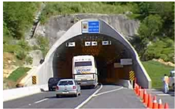
ILUSTRAÇÃO 103 – Túnel Morro do Boi (c/ insolação) FONTE - MINISTÉRIO DOS TRANSPORTES, 2006
