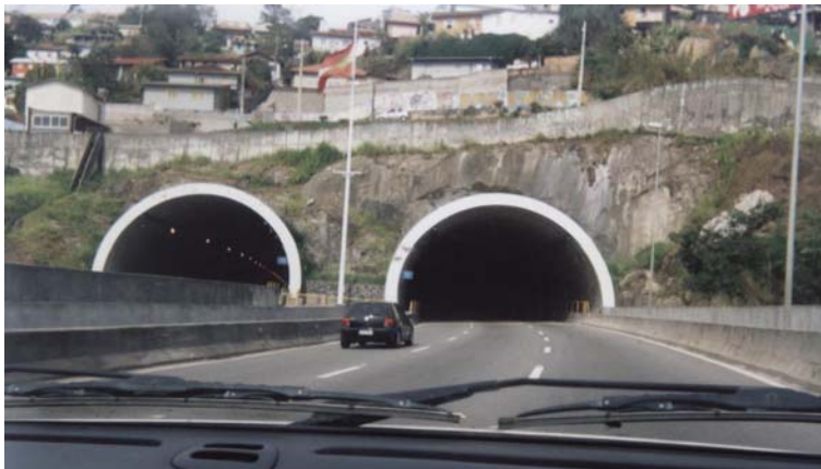
ILUSTRAÇÃO 101 – Túneis da Via Expressa Sul Florianópolis, SC
