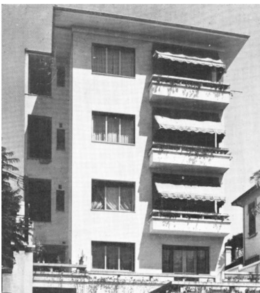
ILUSTRAÇÃO 64 – Reforma de Residência Pacaembu São Paulo, SP: Henrique Mindlin. Solução Composta: Sacada e Toldo FONTE - YOSHIDA et al., 1975, p.101
