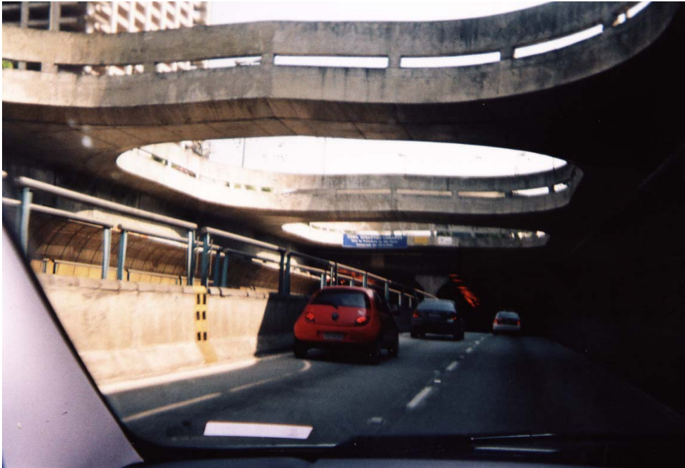
ILUSTRAÇÃO 100 – Túnel Jânio Quadros: Detalhe do Emboque
