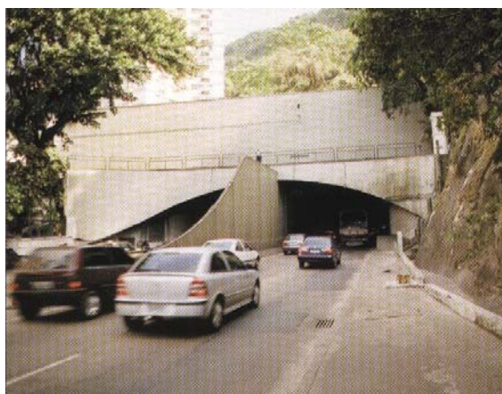
ILUSTRAÇÃO 106 – Túnel Santa Bárbara FONTE – CBT, 2006, p.83
