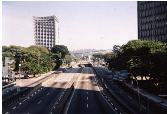
ILUSTRAÇÃO 99 – Túnel Jânio Quadros: Vista Geral
