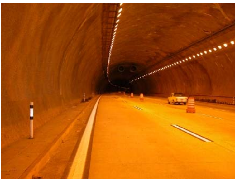
ILUSTRAÇÃO 108 – Vista das Faixas Interditadas no Interior do Túnel (TE-2)
