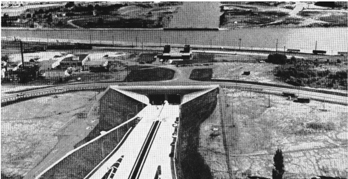
ILUSTRAÇÃO 190 – Túnel Thorold: Vista Geral do Emboque Oeste FONTE – IES, 1970. p.163
