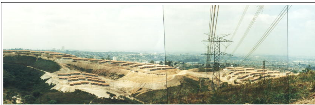
Foto 4: Visão geral dos Empreendimentos Jova Rural I e II
