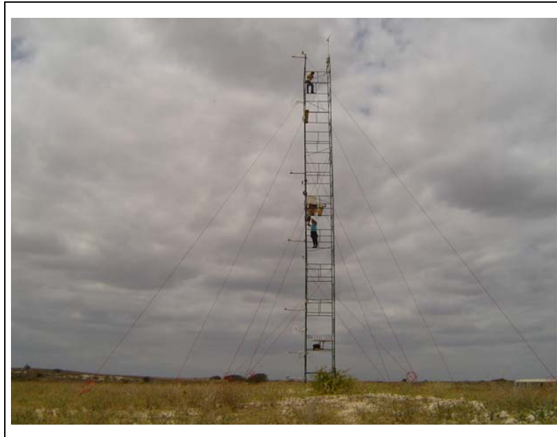
Figura 4.2 – Torre Micrometeorológica montada na cidade de Macau – RN.
