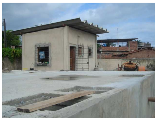
Figura 42: Estação de Tratamento de Esgotos de Jardim Uchôa em construção. Foto da autora, 2007.
