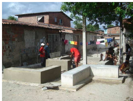
Figura 58: Acesso à Beira Rio depois das obras. Fotos: Sesan-PCR, 2007.
