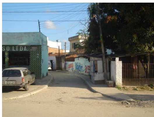
Figura 54: Rua Locutor Abílio de Castro depois das obras. Fotos: Sesan-PCR, 2007.
