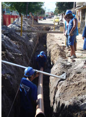
Figura 16: Detalhe da construção de rede coletora. Foto: Cedida pela Sesan – PCR.
