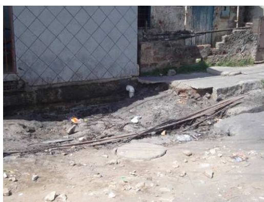
Figura 14: Detalhe de tubulações inadequadas para abastecimento de casas. Foto: Cedida pela Sesan - PCR.
