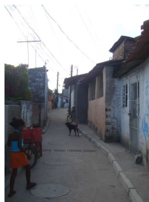
Figura 47: Rua Waldemir Telles depois das obras.
