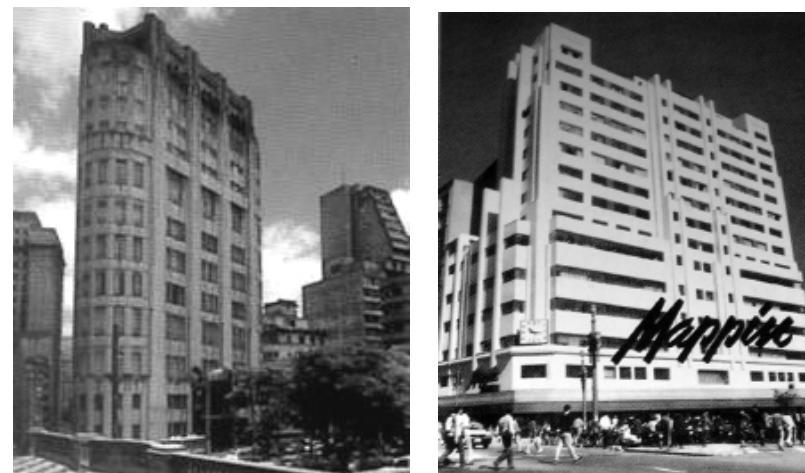
Edifício Saldanha Marinho e Edifício João Brícola ( fig.40)
