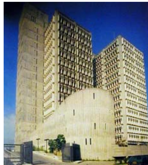
Condomínio São Luis (fig.132)
