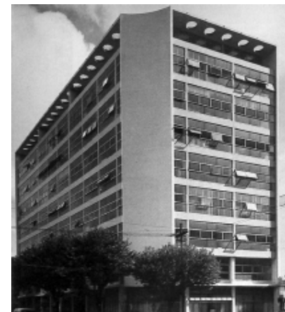
Edifícios Gibraltar (ABC), de Oswaldo Bratke ( fig.50)
