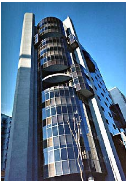
Edifício Uchoa Borges (fig. 125)
