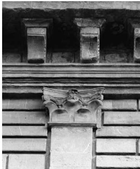
41. Palazzo Rucellai. Pormenor do capitel corintio
