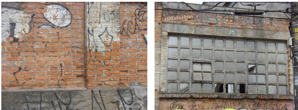
Figs. 87 e 88: Detalhe do aparelho flamengo e encamisamento da estrutura portante (E). Aspecto de uma das aberturas frontais característica dos edifícios, na qual se nota a estrutura pré-moldada, além de uma verga instalada abaixo de outra estrutura, em arco pleno (D). Fotos do autor, 2005.
