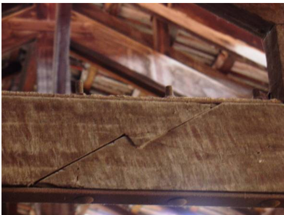
Fig. 25: Ligação feita através de ranhuras compatíveis do tipo “dardo de Júpiter”, reforçada por chapa de ferro e parafusos de cabeça redonda com porcas. Cf. SEGURADO, João Emilio dos Santos. op. cit. , p. 79, 210-11. Foto do autor (2005).
