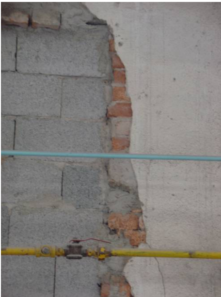
Fig 16: Remoção de forno a gás. Esta abertura, motivada pela remoção de um dos fornos da fábrica, revela a alvenaria de tijolos encoberta pelo reboco. O fechamento do vão, como se pode perceber, é feito displicentemente com o uso de técnicas contemporâneas, empregando blocos de concreto – por sinal, de largura inferior à da parede original – e argamassa de areia, cal e cimento. Foto do autor (2005).
