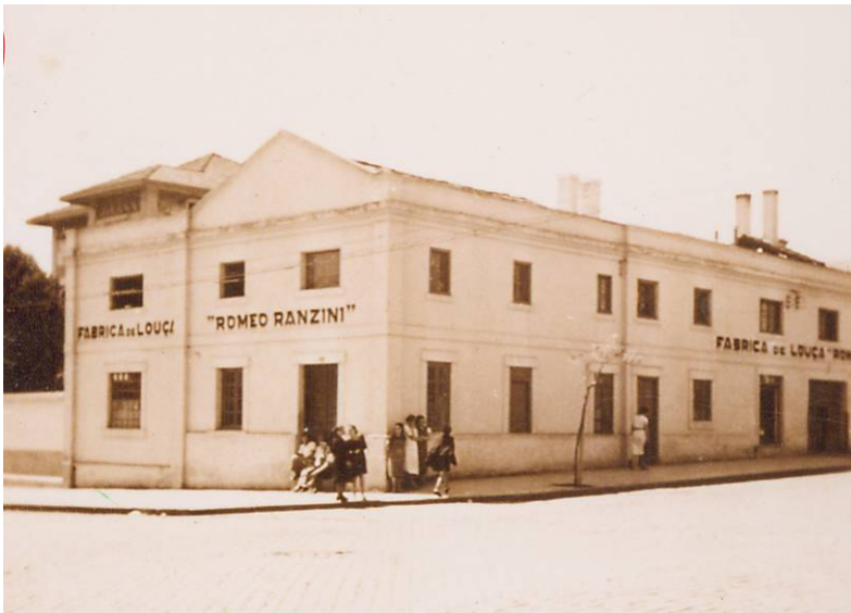
Fig. 59: Fachada da Fábrica de Louças “Romeo Ranzini”, década de 1930. Autor desconhecido. Ausência de beirais e linhas simplificadas caracterizam esta parte do conjunto, implantada na esquina das ruas Duílio (E) e Clélia (D). A seqüência do edifício, que não aparece na foto, constitui-se do núcleo inicial expandido, aos quais se associam as chaminés dos fornos (do centro para a direita). Fonte: Reprodução do original, in: COLEÇÃO RANZINI. Acervo do Museu Paulista/USP.
