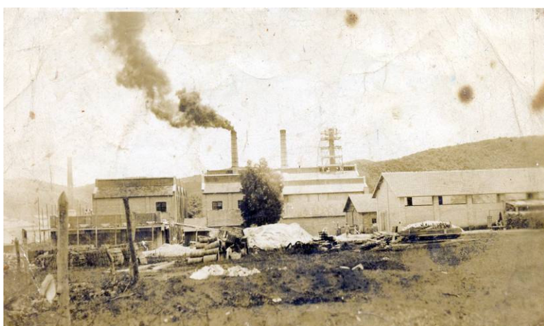
Fig. 79: Galpões da Porcelana Mauá. Autor e data desconhecidos. Em primeiro plano, à direita, dois galpões cujas formas e dimensões sugerem que sejam depósitos ou outras instalações auxiliares. À esquerda, as duas seqüências de galpões permanecem sem ligação na parte frontal. Ao centro, as três chaminés dos fornos, estando uma delas (a da direita) em construção. Fonte: Acervo do Museu Barão de Mauá. RG 2749.
