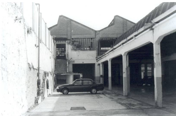
Fig. 86: Parte interna da Porcelana Mauá, caracterizada pelo uso de estruturas em concreto armado. Além de edificações verticalizadas, notam-se os pilares com capitel característicos deste sistema construtivo, no qual se privilegiou a modulação dos galpões com planta livre. Fonte: CARAMORI, Leonardo C.; FREITAS, Pedro Murilo G., op. cit. , fig. 10. Foto dos autores, 2003.
