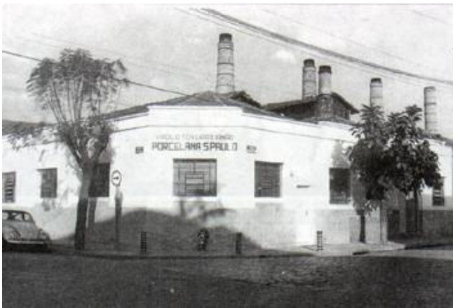
Fig. 13: Fachada da Porcelana São Paulo, em 1976. No primeiro plano o núcleo inicial, seguido dos galpões e aspectos da cobertura da fase 2 . Note-se a orientação dos edifícios, perpendiculares à Rua Major Carlo del Prete, e as chaminés aparentes, que correspondem aos cinco fornos em funcionamento na época. Esta localização sugere, ainda, a concentração das etapas de queima neste setor da fábrica. Autor desconhecido. Acervo da Fundação Pró-Memória de São Caetano do Sul.
