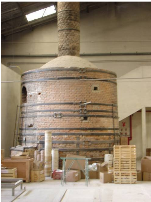
Figs. 18 e 19: Forno “Memorial” e seu interior. O fechamento da abóbada, levemente curvado, difere do executado posteriormente em outro forno (fig. 20), no qual a conicidade é mais acentuada. O detalhe indica o uso de refratários na construção dos fornos. Sua superfície, sinterizada pela ação do calor, guarda ainda informações sobre o assentamento destes materiais. Fotos do autor (2005).
