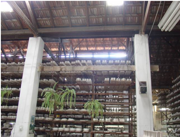
Fig. 22: Detalhe da junção entre galpões. Em primeiro plano, estão os pilares que sustentam as tesouras e as duas terças paralelas, nas quais se apóiam os caibros da cobertura em telhas do tipo “Marselha”. Essa cobertura denota o uso intermitente de elementos transparentes, visando ao aproveitamento da luz natural. Na parte superior, situado entre as terças, têm-se o coletor propriamente dito, e logo abaixo desta, a entrada de luz amplamente favorecida pela fenestração. Foto do autor (2005)
