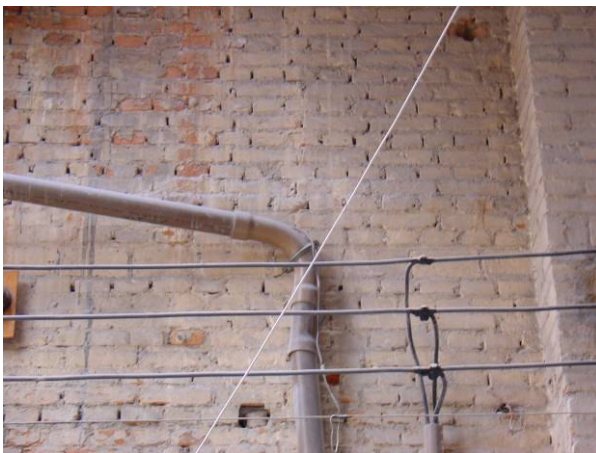
Fig. 14: Exemplo do emprego do sistema inglês, em sua variação alentejana, o “trincado”, que remonta às origens lusitanas. Este padrão figura em outros pontos das edificações analisadas e em uma fotografia da fase 2 datada de 1954 (fig. 17). Foto do autor (2005).
