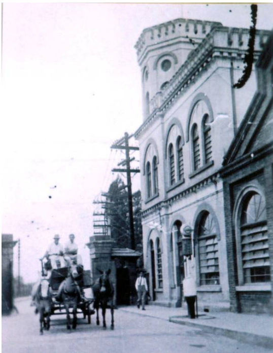
Fig. 65: Portaria da Fábrica de Louças Adelinas. Autor e data não identificados. Além dos aspectos comentados acima, vale notar a presença de uma guarita, situada ao lado do portão e, ao fundo dessa, os postes da rede elétrica. Acervo da Fundação Pró-Memória de São Caetano. ID 1044.
