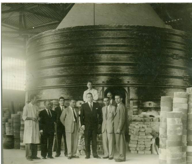
Fig. 20: Este forno, fotografado em 1954, apresenta dimensões e execução diferenciadas em relação ao anterior, não somente por apresentar uma abóbada de conicidade mais acentuada do que a daquele, mas também pela ausência das saídas superiores (respiros). Outro detalhe interessante desta fotografia é a presença dos refratários utilizados como lastros nas queimas e para recomposição da parte interna. Acervo da Porcelana Teixeira.
