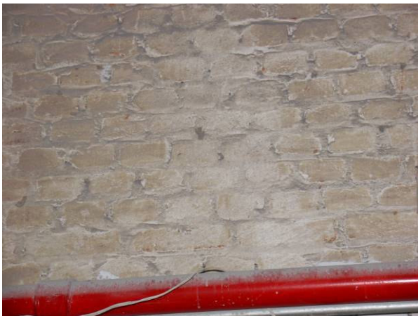
Fig. 15: Parede de uma vez de tijolo, captada em um dos galpões do conjunto de 1932 ( fase 4 ). Foto do autor (2005).
