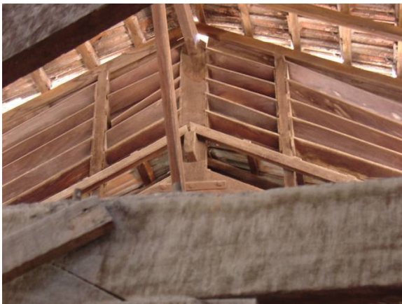
Fig. 23: Detalhe da veneziana. Localizada nos fechamentos de frente e fundo do lanternim. Foto do autor (2005).
