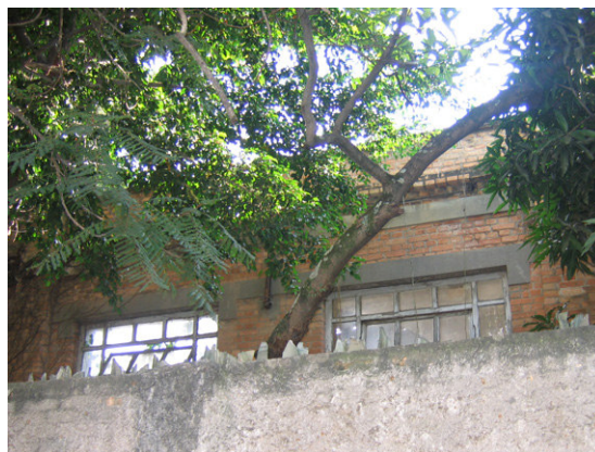
Fig. 72: Detalhe da cimbalha e caixilhos em cimento armado pertencentes ao edifício do refeitório. Foto do autor, 2006.
