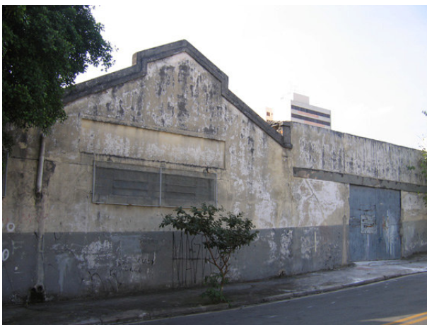
Fig. 21: Detalhe de parte externa do conjunto fabril (Rua José Ferrari) Revestido por argamassa, apresenta formas apreensíveis em outros edifícios construídos na década de 1930, nos quais o desenho dos telhados influenciava a aparência externa. Nesta fachada, percebe-se o coroamento nos arremates dos pilares de ligação, e um emolduramento que pode significar o fechamento de vão ou o deslocamento de caixilho. Foto do autor (2005).
