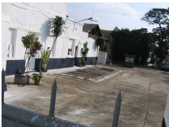
Fig. 73: Edifício de escritórios, visto da portaria. Foto do autor, 2006.
