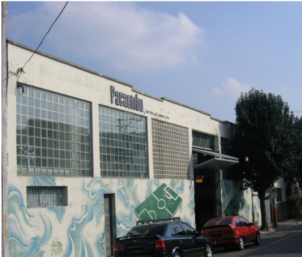
Fig. 11: Fachada de edifício da fase 3 (Rua Conceição), atualmente ocupado por empresa de têmpera de vidros. Note-se o uso de platibanda como meio de esconder o telhado, cujo desenho remete ao projeto original, de 1948. Foto do autor. (2006).
