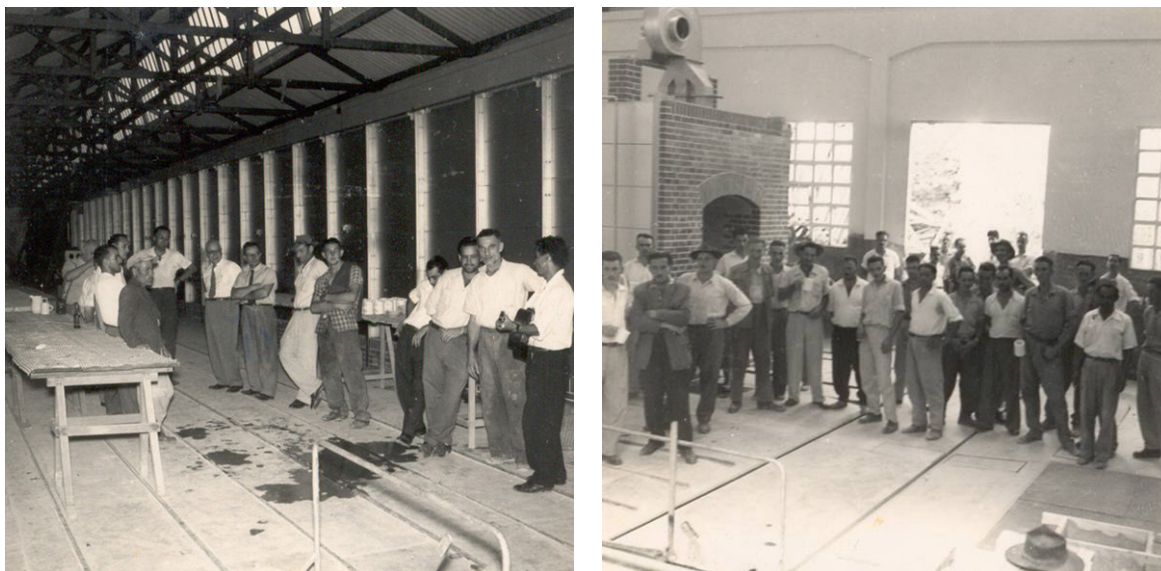
Figs. 84 (E) e 85 (D): Interior da Porcelana Mauá. Autor e data desconhecidos. Além da presença marcante dos trilhos, é possível perceber as características do tipo de cobertura adotado (E), além da abertura do forno-túnel e os vãos destinados à iluminação, ventilação e acesso. Note-se, ainda a diferenciação entre a ossatura e a vedação, demarcadas pelos pilares e pela viga de sustentação (D). Fonte: Acervo do Museu Barão de Mauá. RG s . 2510 e 2507, respectivamente.
