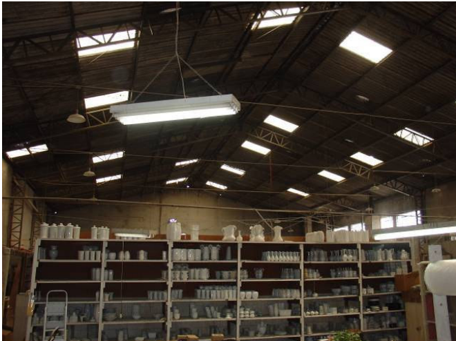
Fig. 26: Detalhe do galpão da fase 2, após a reforma de 1986. Nesta ocasião foi utilizada a cobertura em telhas de fibrocimento sobre estrutura metálica. Os elementos transparentes, no entanto, foram aplicados como forma de favorecer a iluminação natural. Outro detalhe é a sustentação destas estruturas por colunas também metálicas, de perfis em treliça, dispensando os históricos pilares em alvenaria de tijolos. Foto do autor (2005).
