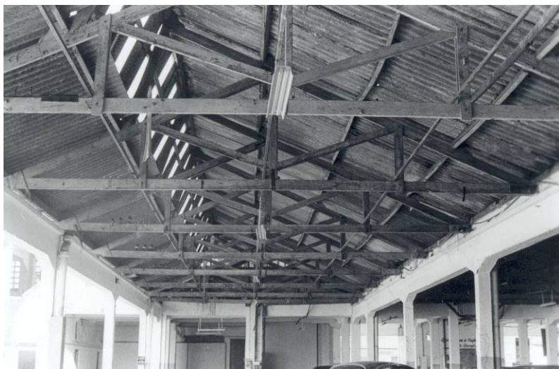
Fig. 89: Detalhe da cobertura da Porcelana Mauá. Apesar de descaracterizada ao longo das últimas décadas, ainda é possível verificar aspectos da estrutura das tesouras e do sistema de iluminação e ventilação adotado. Fonte: CARAMORI, Leonardo C.; FREITAS, Pedro Murilo G., op. cit. , fig. 4. Foto dos autores, 2003.
