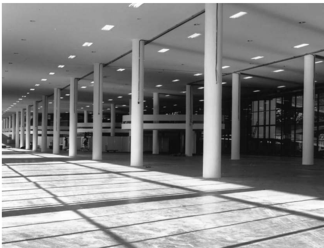
Imagens 19 e 20 - Vistas internas do Palácio das Indústrias (pavimento térreo e mezanino). Fonte: Centro de Documentação “Francisco Matarazzo Sobrinho” do Arquivo Histórico Wanda Swevo da Fundação Bienal de São Paulo.
