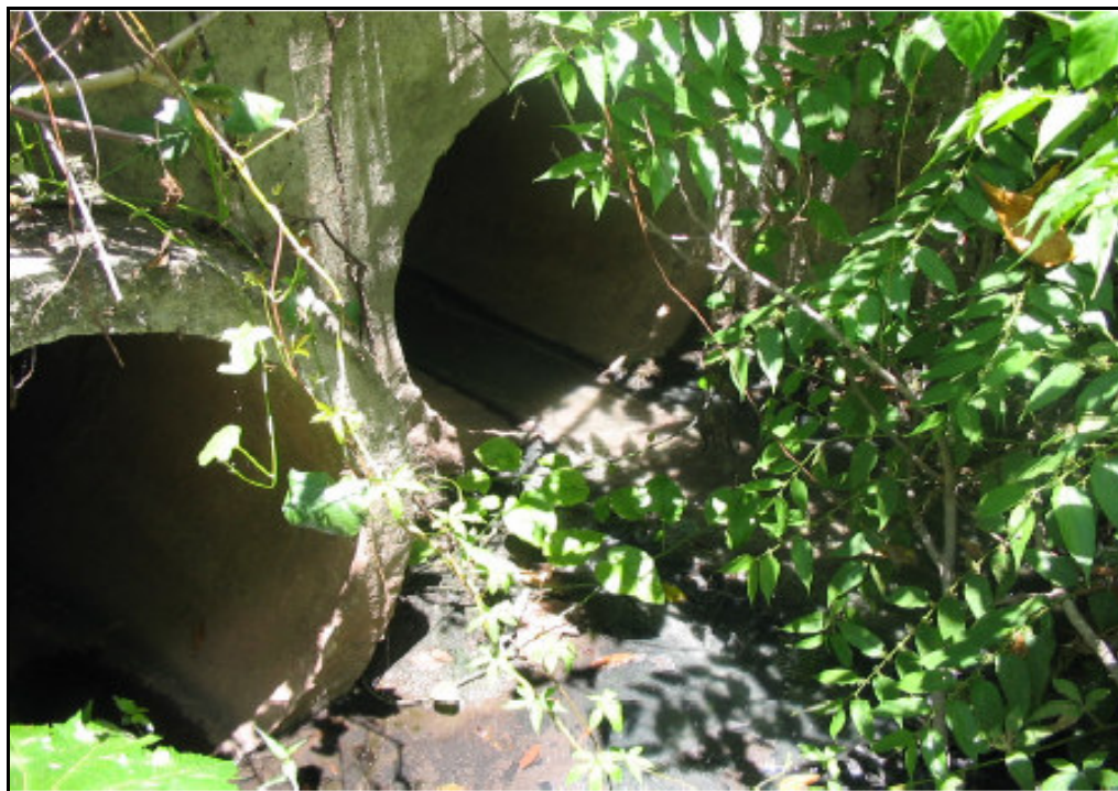
Figura 11. Foto da galeria de esgoto com escoamento de água residuária.
