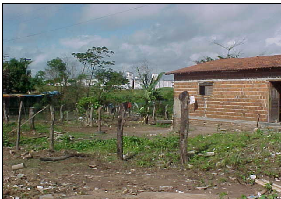
Figura 21. Foto da construção irregular as margens do Rio do Cabelo a montante da nascente
