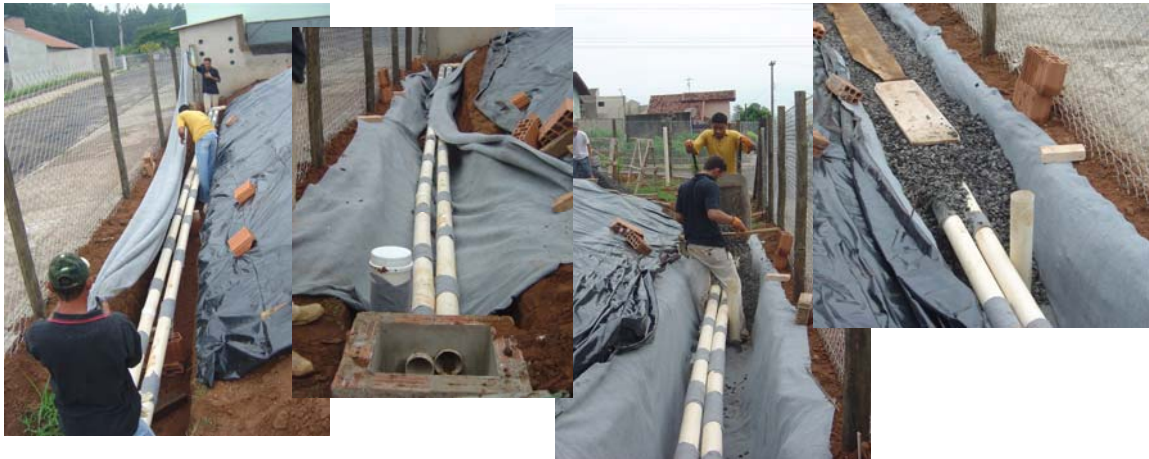
Figura 4.14 - Revestimento em manta geotêxtil da valeta escavada e cobertura de preenchimento com brita para formação da trincheira de infiltração.
