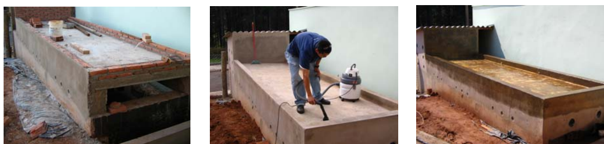
Figura 4.7 - Obras civis do telhado verde, limpeza e aplicação de resina impermeabilizante.
