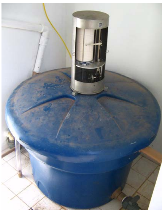
Figura 4.23 - Monitoramento das águas pluviais que escoam do telhado verde utilizando o linígrafo manual de bóia.
