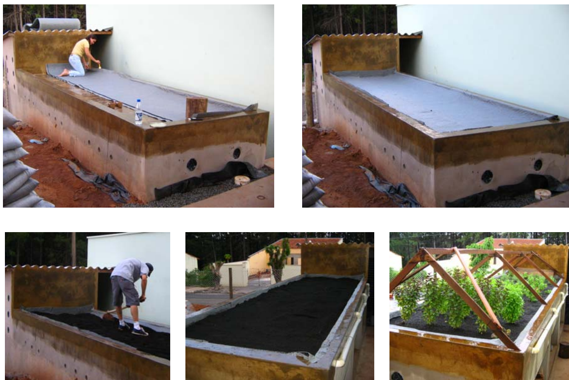
Figura 4.9 - Aplicação de manta geotêxtil, substrato e plantio para composição do telhado verde.
