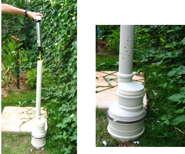
Figura 4.25 - Poço 2 de monitoramento da trincheira com instalação do linígrafo.
