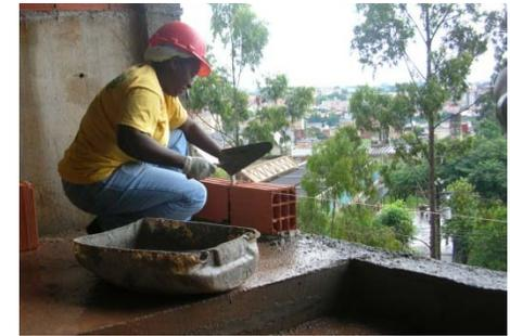
Figura 28 – Mutirante construindo a parede.
