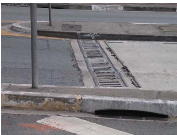
Foto 20 - Grelha de concreto na embocadura do túnel.
