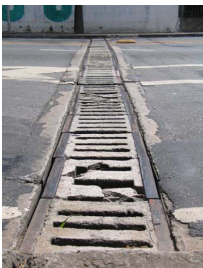
Foto 19 - Grelha de concreto para coleta de águas pluviais junto à embocadura do túnel.
