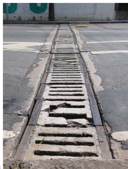
Figura 26 - Grelha de escoamento de água pluvial, no Ponto 3 de medição.
