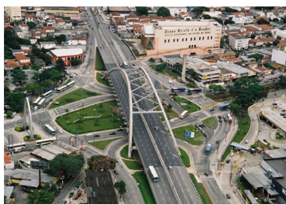
Fig. 08 - Vista do viaduto da Avenida dos Autonomistas sobre a Praça Manoel Coutinho.
