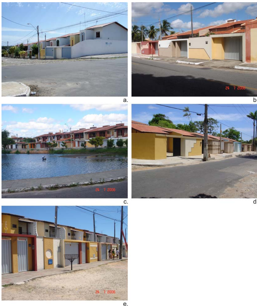
Ilustração 23. Fotos ilustrativas de casas em série na zona sudeste de Fortaleza. a, e, Bairro Sapiranga/Coité. b, Bairro Cambeba. c, Bairro Cidade dos Funcionários. d, Bairro Parque Manibura. Fonte: autora, 2006.
