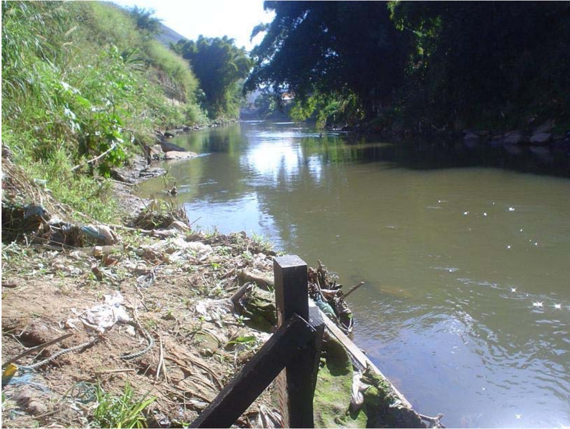
Figura 4.7 – Seção de Pedro do Rio – vista para jusante
