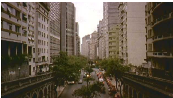
FIG 51 – Viaduto da Borges Fonte: Filme Sal de Prata
