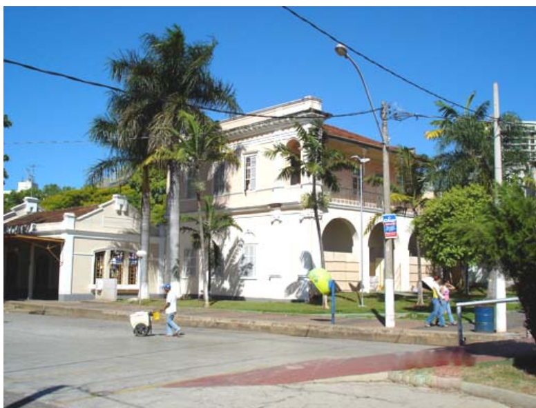
Foto 27 – Edifício Histórico na praça: Casa do Chefe.
