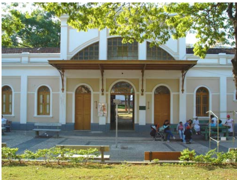
Foto 26 – Edifício Histórico na praça: a Estação.
