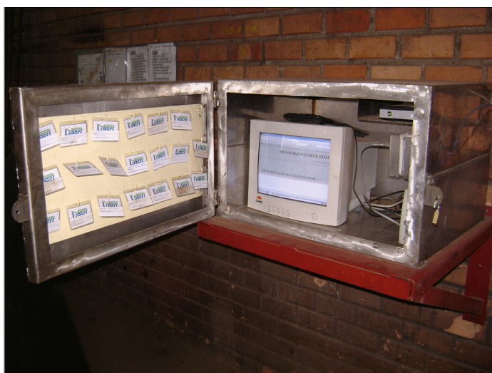
Figura 2 – Equipamentos utilizados para o monitoramento automatizado
