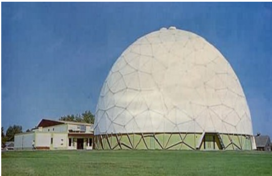
Figura 7 - radomo para proteção de antenas - ( www.radomes.org ) [27]
