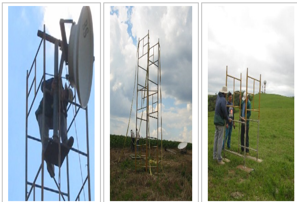
Figura 28 - Infra-estrutura de campo montada para as medições
