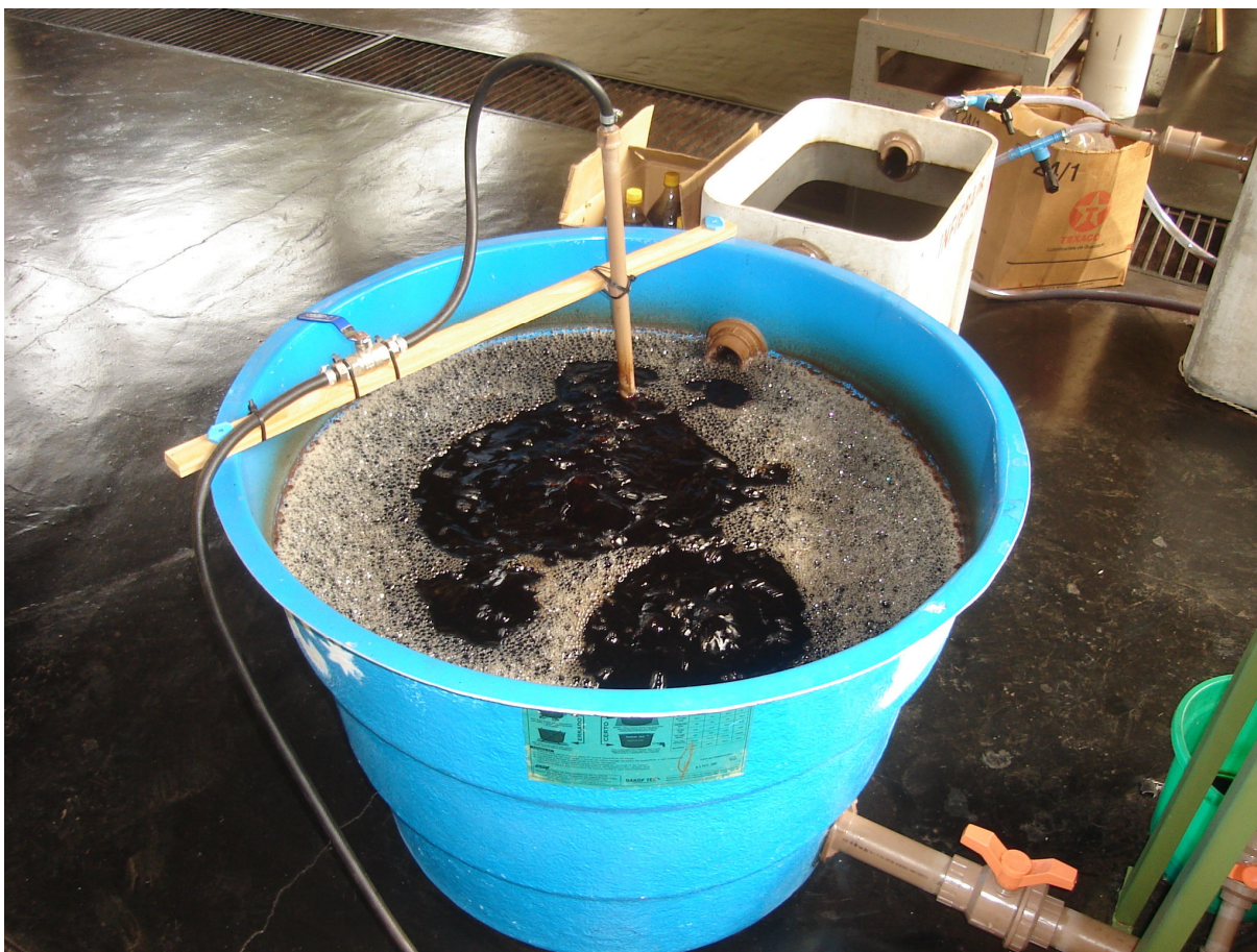
Tanque de aeração e decantador do sistema 1.
