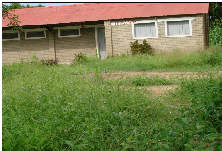
Figura 7 - Escola da comunidade recentemente construída
