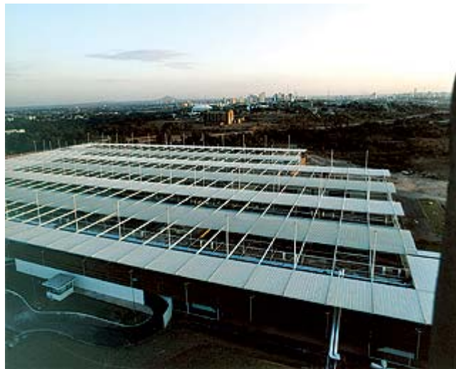
Figura 22: cobertura metálica do complexo forense Fonte: Melendez, 2005
