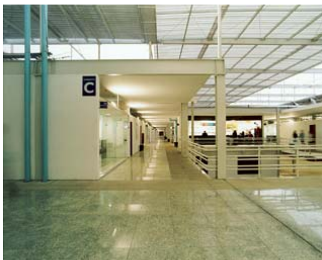
Figura 25: Estrutura metálica e instalações aparentes no Fórum de Cuiabá Fonte: Melendez, 2005
