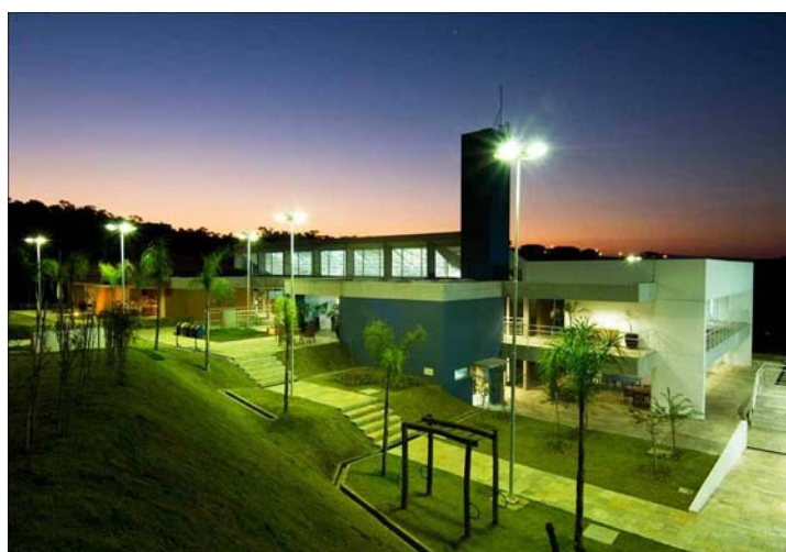
Figura 29: Clube e áreas comuns do residencial Gênesis II Fonte: Y. Takaoka, 2008
