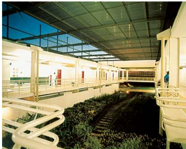
Figura 24: Pátio interno ajardinado com os blocos laminares avarandados Fonte: Melendez, 2005
