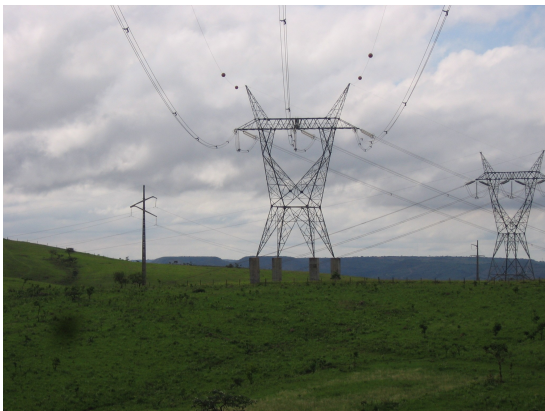
Torre RB30 apoiada em fundação "Sapata"
