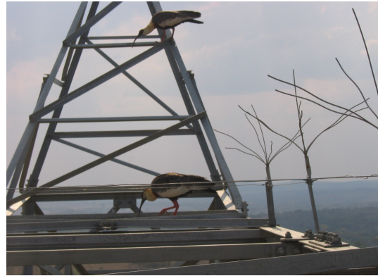
Curicacas na estrutura e sistema de proteção
