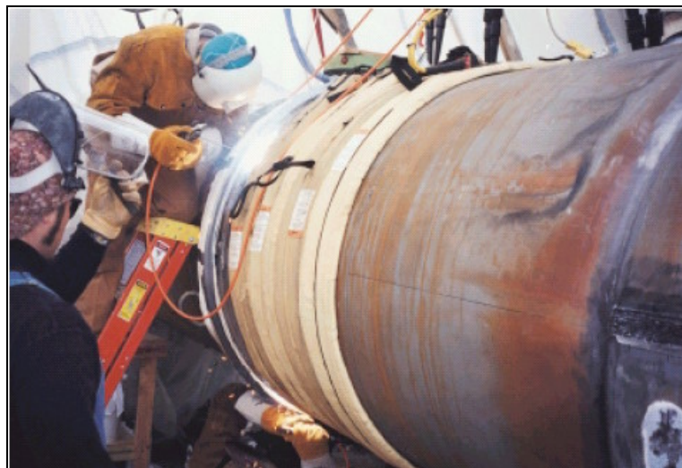
Figura 2.9– Pré-aquecimento por indução para trepanação de tubo na Trans-Alaska Pipelines [26].
