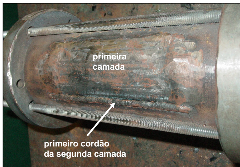
Figura 4.80- Primeira camada de solda depositada sobre o revestimento aspergido na área de dano e primeiro cordão da segunda camada.
