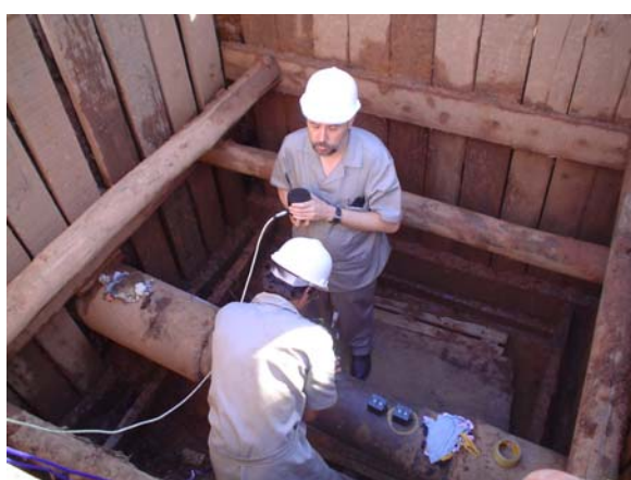
Figura E.15 Medição em campo com o MTRES Modular. Detalhe da medição de tensões residuais em dutos
