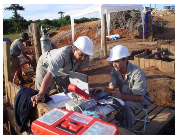
Figura E.16 Medição em campo com o MTRES Modular. Detalhe do sistema de aquisição de imagens.
