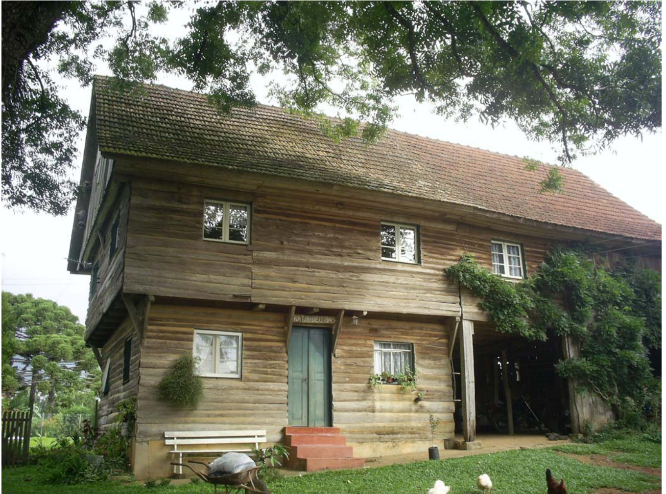
Casa da família Maus, construída na colônia Terra Nova em 1934, com paredes duplas de tábuas e costaneiras. Foto AK, 2007.
