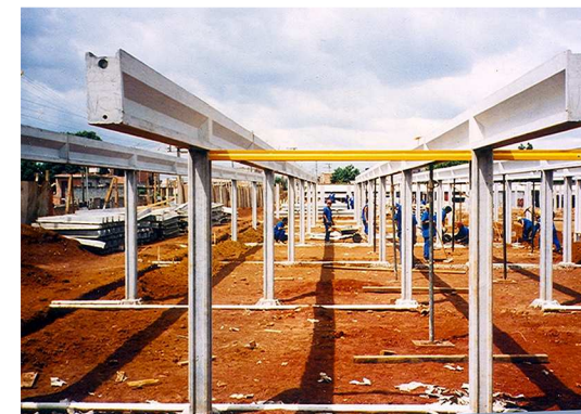
Imagem 75: Montagem de escola com componentes pré-fabricados do Cedec Foto de Reginaldo Ronconi
