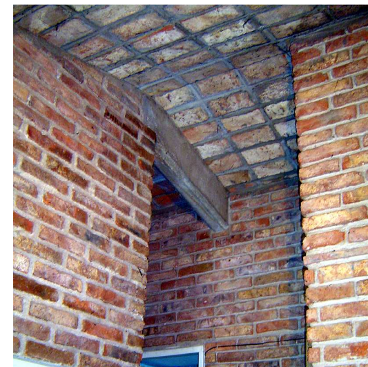
Imagem 64: Laje de cobertura da cooperativa Covimt 1
