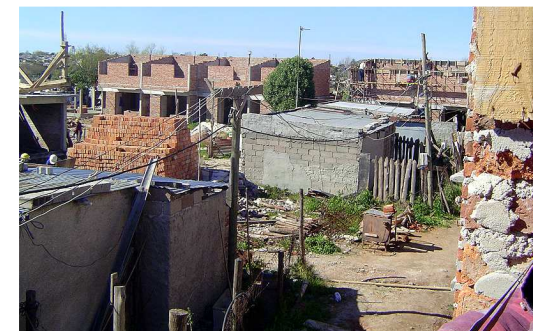
Imagem 69: Canteiro de obras da cooperativa Covilacar
