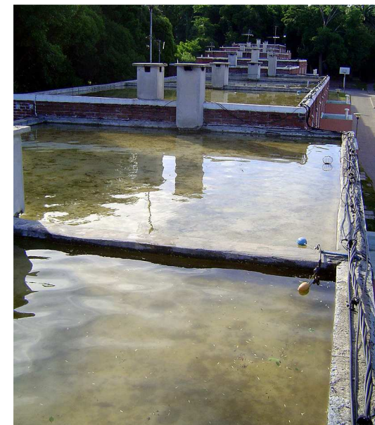
Imagem 66: Isolamento com água na cooperativa Tacuabé
