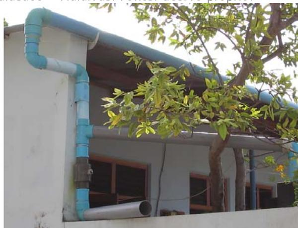
**Figuras 21 e 22:** Sistema de captação de águas pluviais em Thulusdoo – Maldivas. Fonte: acervo próprio.
