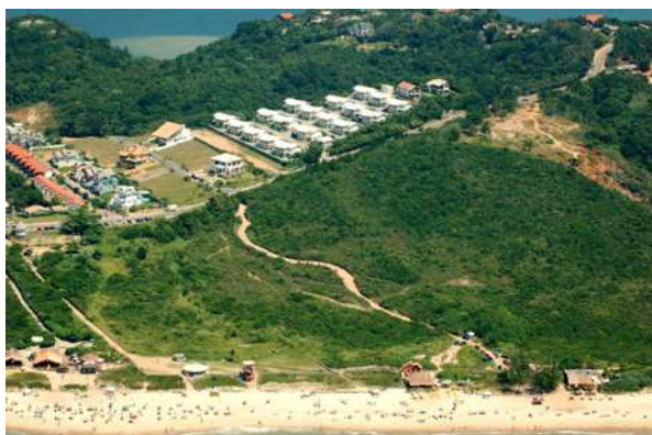
Figura 5.65: Vista de condomínio fechado horizontal na praia Mole.
