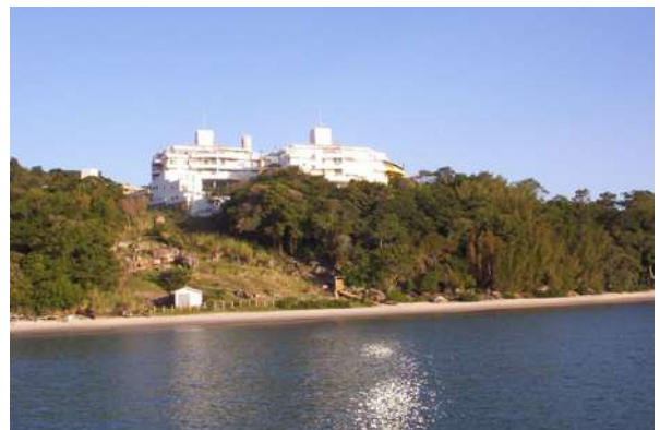
Figura 5.111: Condomínio vertical com muita evidência em promontório em Jurerê.
