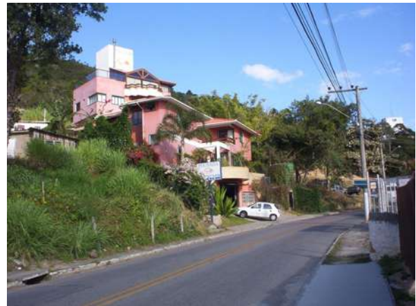
Figura 5.124: Vista de pousada em encosta com impacto similar ao entorno.
