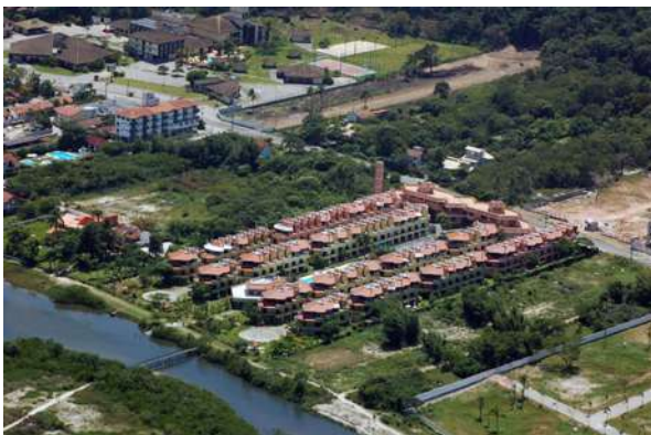
Figura 5.110: Vista de condomínio na Ponta das Canas.
