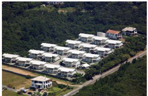
Figura 5.107: Vista do Condomínio evidenciando o excessivo adensamento e a distribuição espacial inadequada.
