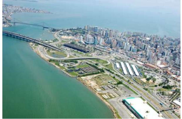
Figura 5.9: Vista do centro insular e pontes. O aterro afastou o centro do mar e facilitou a circulação de veículos.
