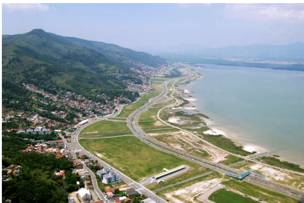
Figura 5.13: Vista da Costeira do Pirajubaé, mostrando aterro novo e encostas ocupadas.
