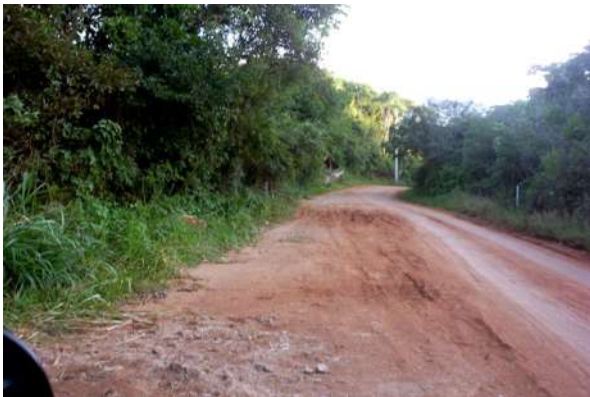
Figura 5.58: Vista de via secundária na U.P.
