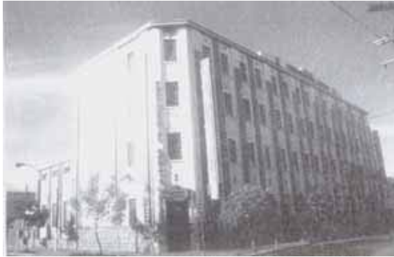
Fig. 2. Edifício do Moinho Chaves
