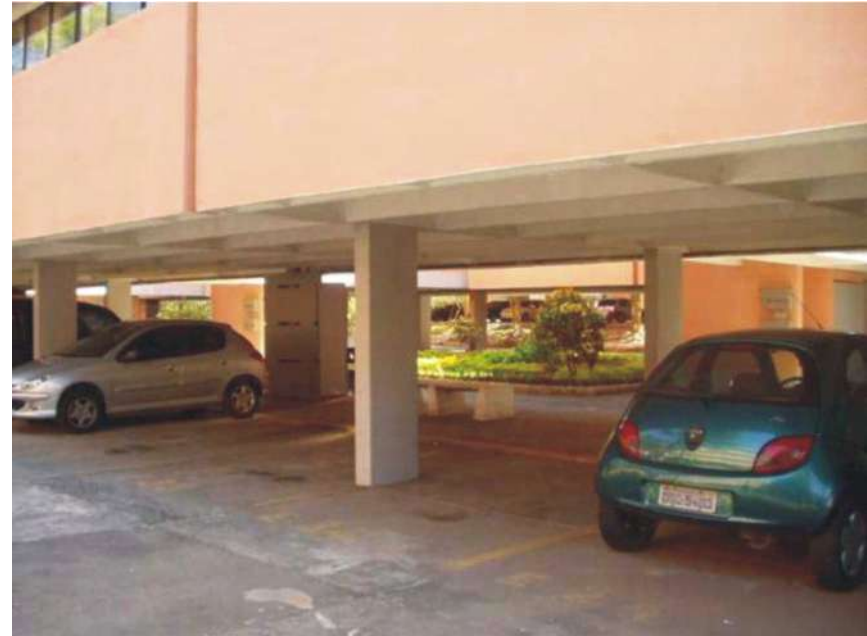
Ilustração 32 - Térreo garagem do condomínio São Paulo. Foto: Solimar Isaac
