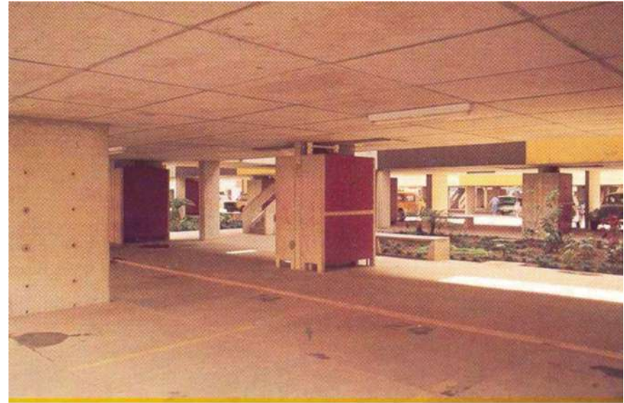
Ilustração 37 - Área do térreo em pilotis. Condomínio Rio de Janeiro. Nesta fase de construção não há mais as vigas aparentes e os pilares são mais robustos. Foto: Acervo CDHU
