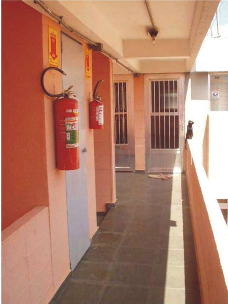
Ilustração 33 - Corredor de acesso aos apartamentos. Terceiro andar da escada. Extintores contra incêndio, e lixeira vertical. Foto: Solimar Isaac
