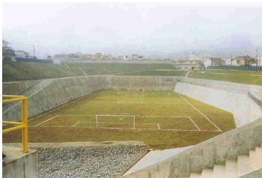
Figura 20: Reservatório de detenção São Bernardo do Campo – DAEE- SP
