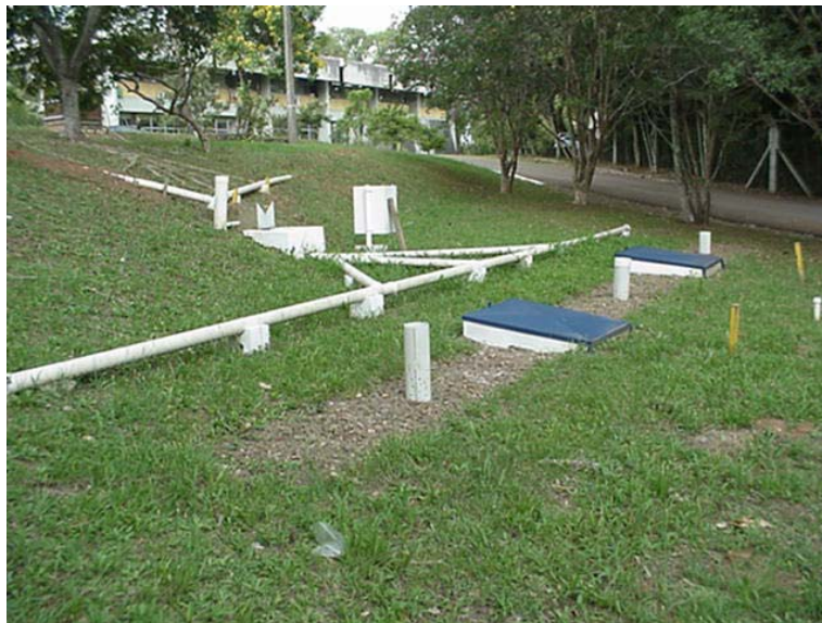
Figura 5 : Trincheira de infiltração Modelo experimental com inspeção Local: I.P.H. Instituto de Pesquisas Hidráulicas Porto Alegre – R.S. Foto do autor / 2003
