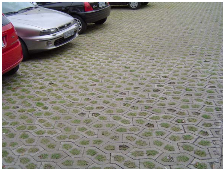
Figura 13 : Pavimento permeável com grama Modelo experimental –área estacionamento - Local: I.P.H. Instituto de Pesquisas Hidráulicas Porto Alegre – R.S. Foto do autor / 2003
