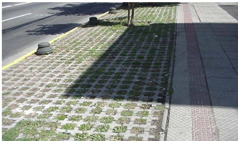
Figura 12 : Pavimento permeável Área urbana de estacionamento Local: Santiago do Chile – Chile 2005 Foto do autor
