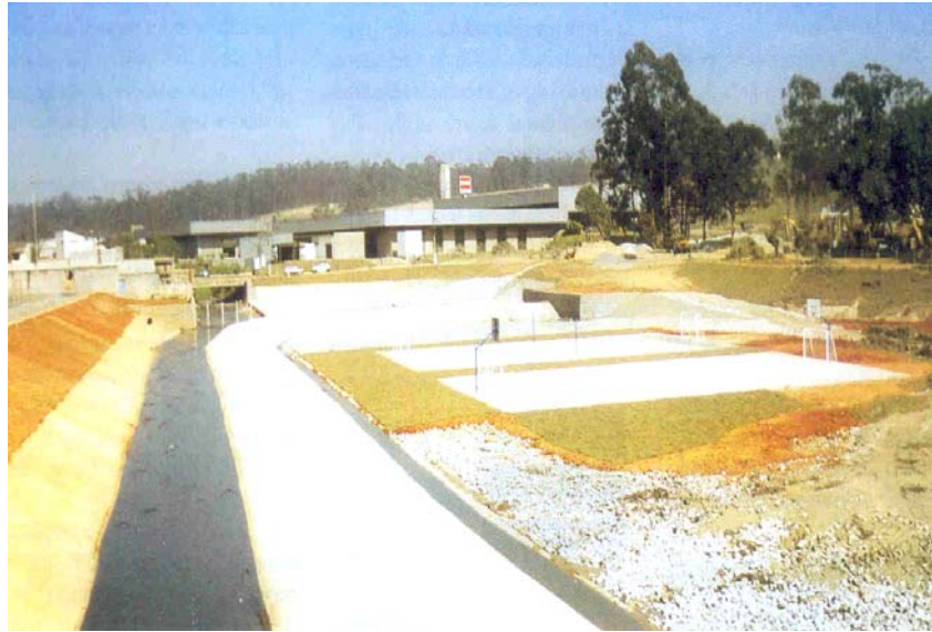
Figura 19: Reservatório de detenção Santo André – DAEE- SP
